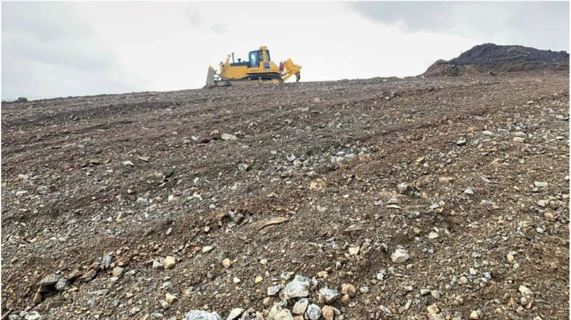
Зураг-3.3. Техникийн нөхөн сэргээлт хийж буй байдал.
