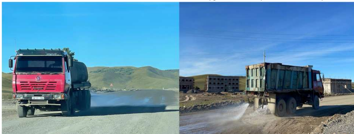
Зураг-2.4.Зам усалгаа хийж буй байдал.
