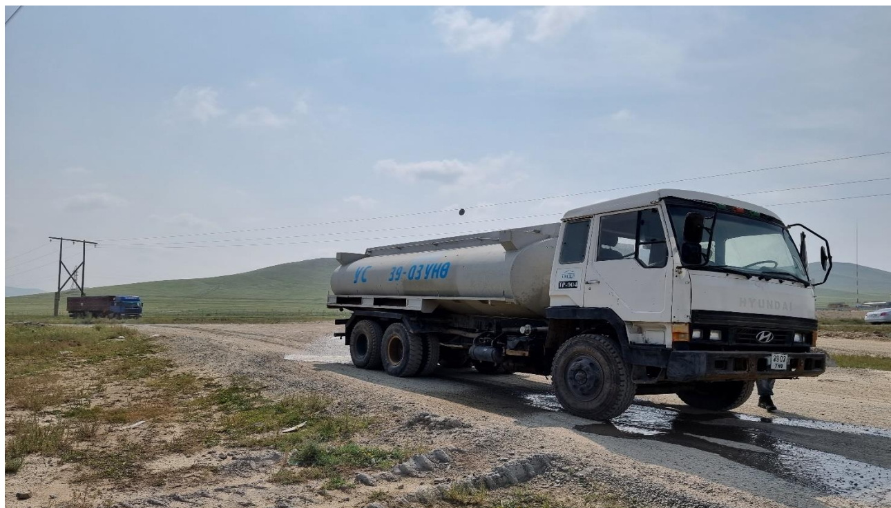
Зураг-2 Бат бэхийн уулзвараас карьер хүртэлх гадна тээврийн замын усалгаа хийгдэж буй байдал
