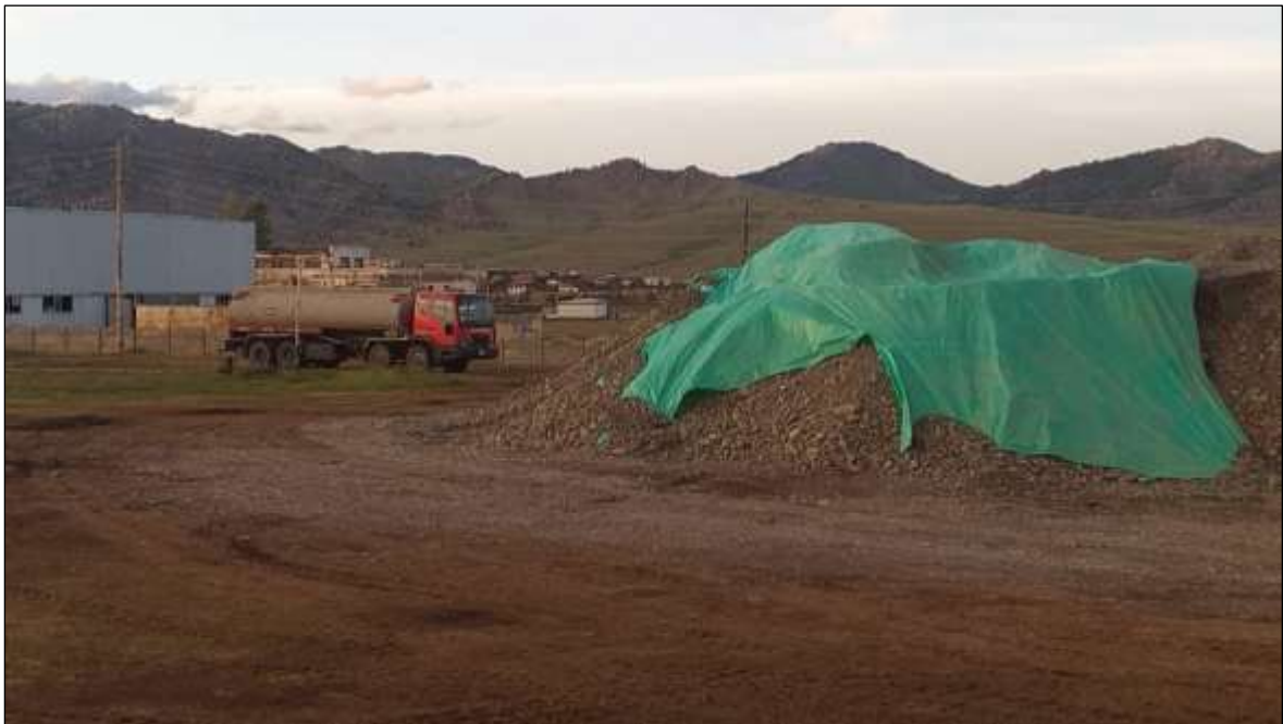
Зураг №10. Тоосжилтийг бууруулах зорилгоор хучилт хийж буй байдал
