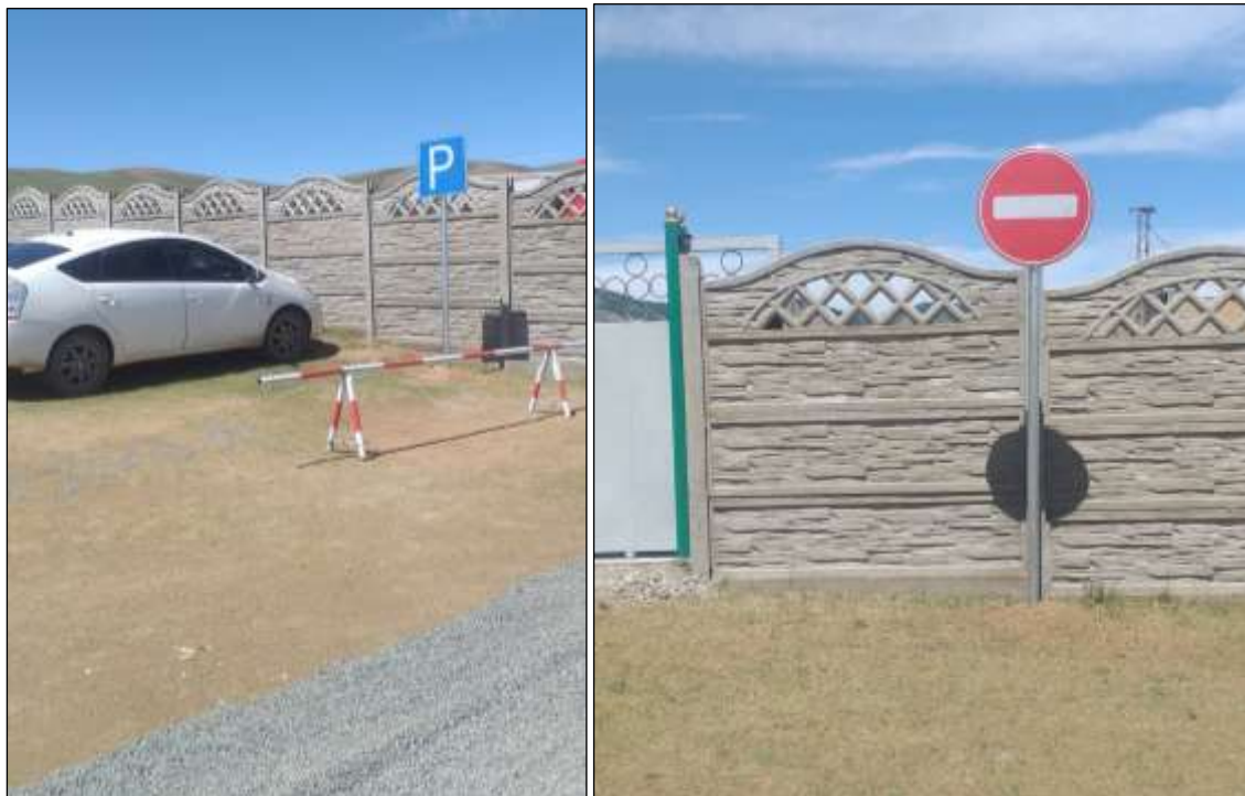
Зураг №15. Замын болон зогсоолын тэмдэг тэмдэглэгээ хийсэн байдал
