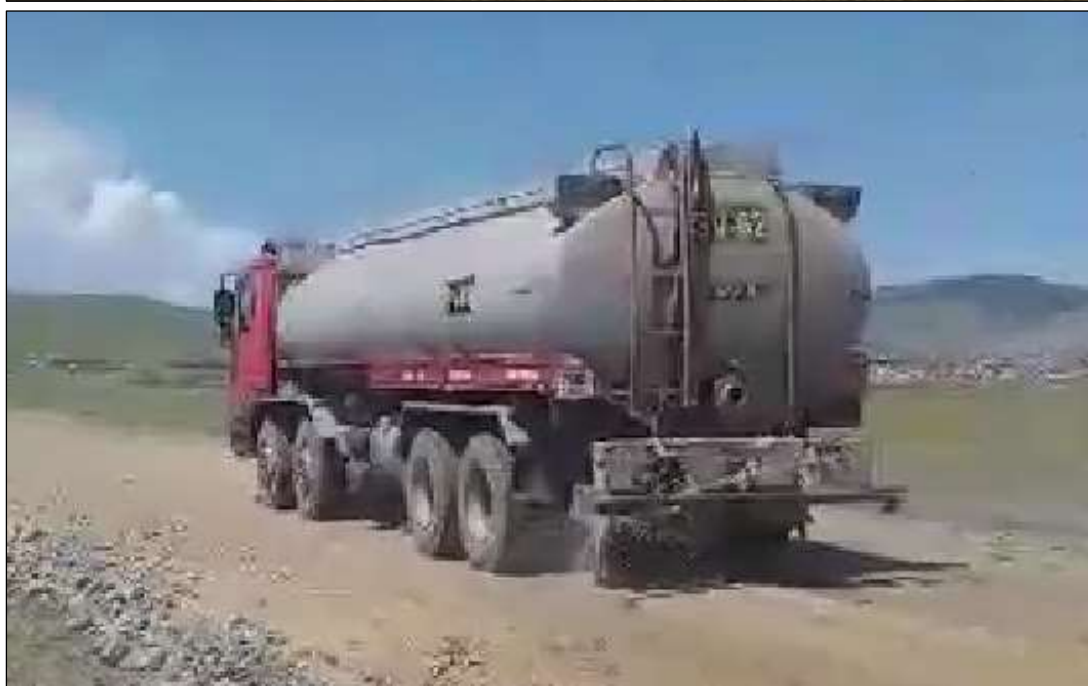
Зураг №9. Зам усалгааны ажил хийгдэж буй байдал
