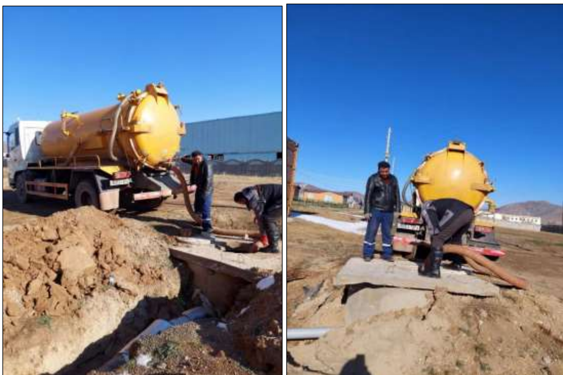
Зураг №14. Ахуйн бохир ус соруулж буй байдал
