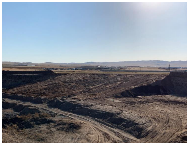
Зураг 13. 0,4 га талбайд 16000м 3 шороо дүүргэлт хийж, мөргөцөгийг 30 0 налуутай болгож техникийн нөхөн сэргээлтийг хийв.
