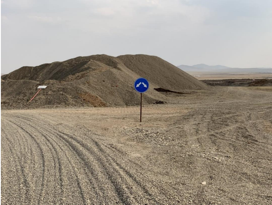
Зураг 3. Уурхайн тоосжилтыг бууруулах зорилгоор хайрга чулуу дэвсэж, услах ажлууд хийгдэв.
