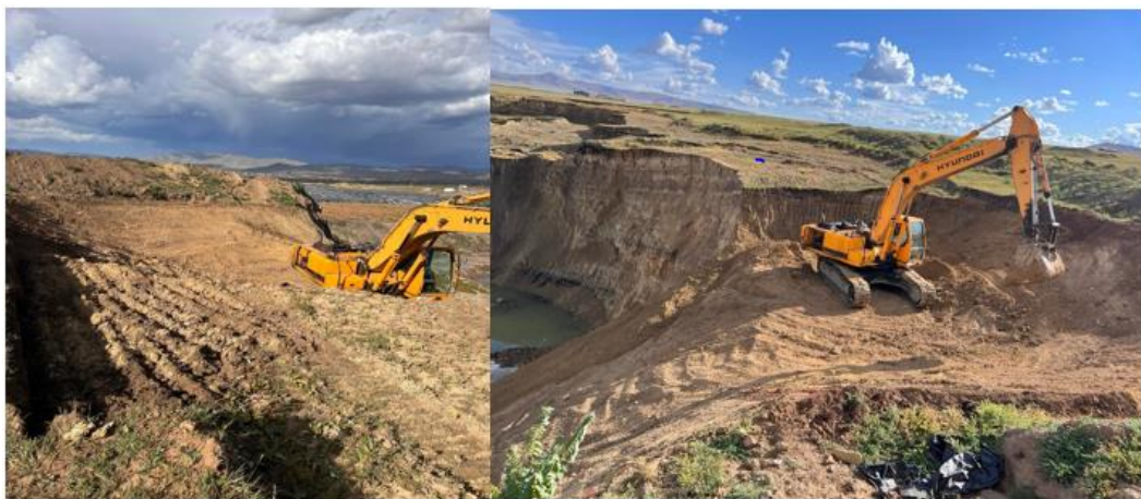
Зураг 9. Нөхөн сэргээлт хийгдэж буй байдал
