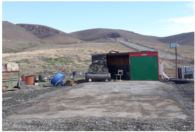
Зураг 7. Засварын газрын талбайн хөрс бохирдохоос сэргийлж бетондсон байдал
