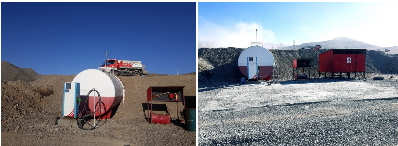
Зураг 4. ШТС-ийн талбай орчмыг бетондсон байдал
