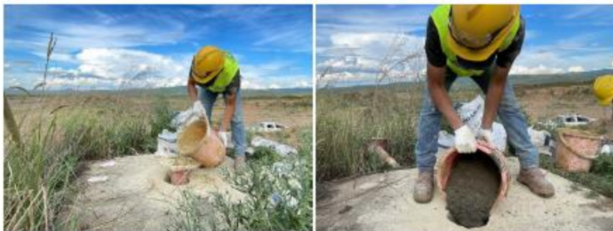
Зураг 4. Цооногуудыг бентонит, бетоноор дүүргэж буй байдал
