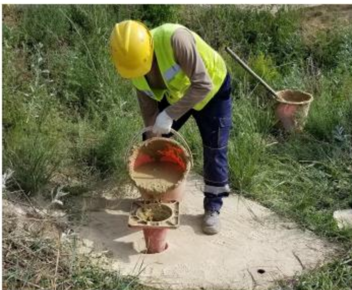
Зураг 13. Цооногт бентонит хийж буй байдал
