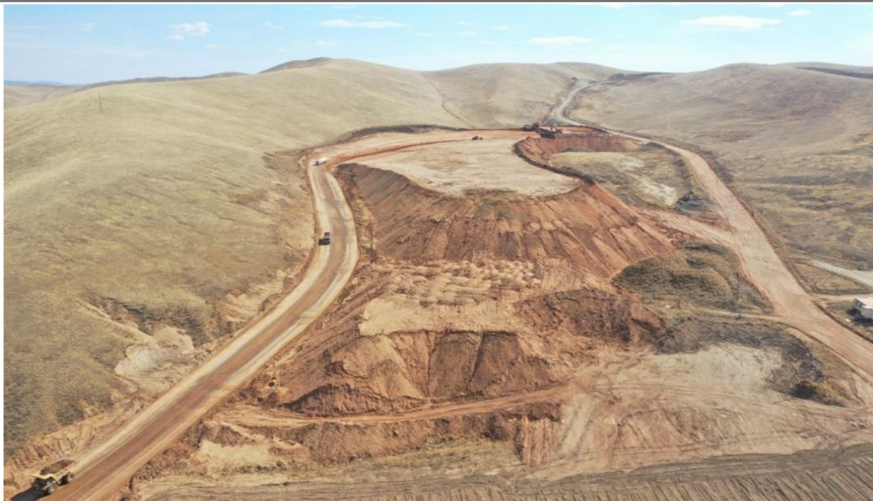
Зураг 26. Гадаад овоолгыг зөөж нөхөн дүүргэлт хийж буй явц
