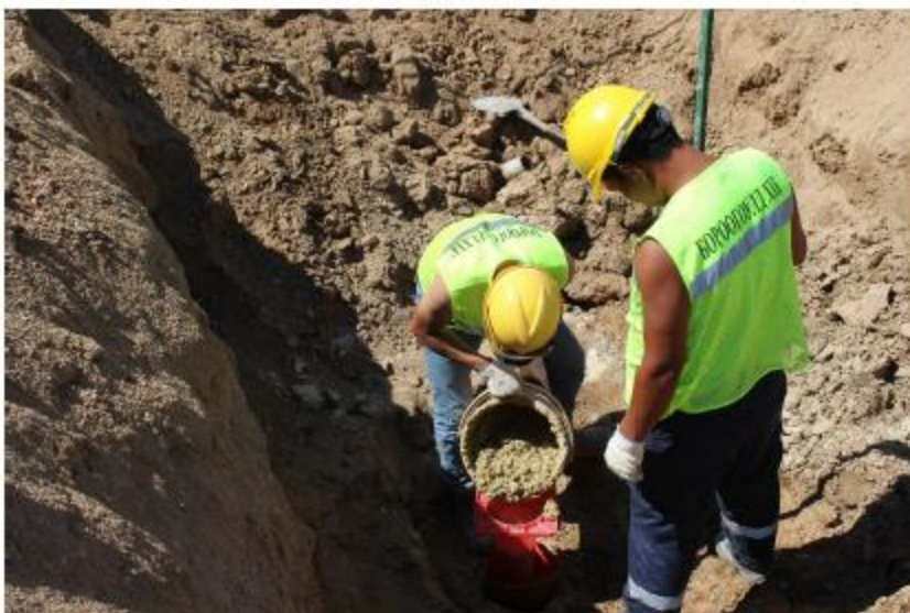
Зураг 18. Цооногт бентонит хийж буй байдал
