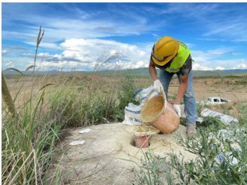
Зураг 24. Цооногт бентонит хийж буй байдал
