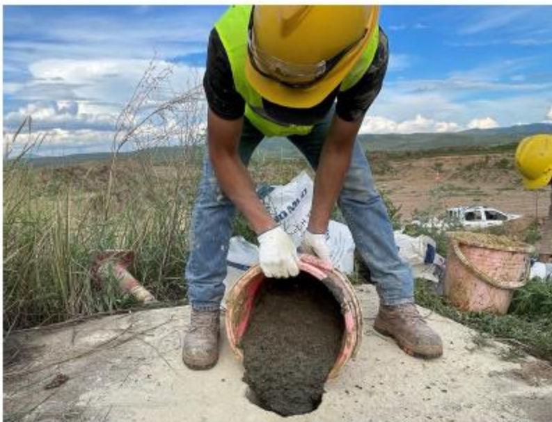
Зураг 25. Бетон дүүргэлт
