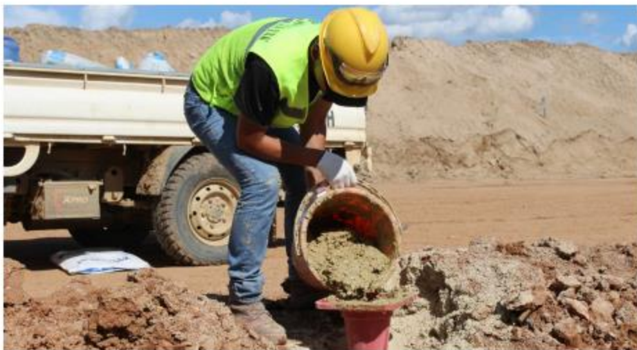
Зураг 30. Цооногт бентонит хийж буй байдал
