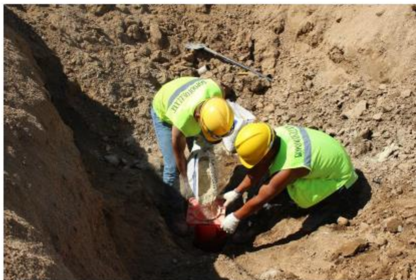
Зураг 17. Цооногт бентонит хийж буй байдал
