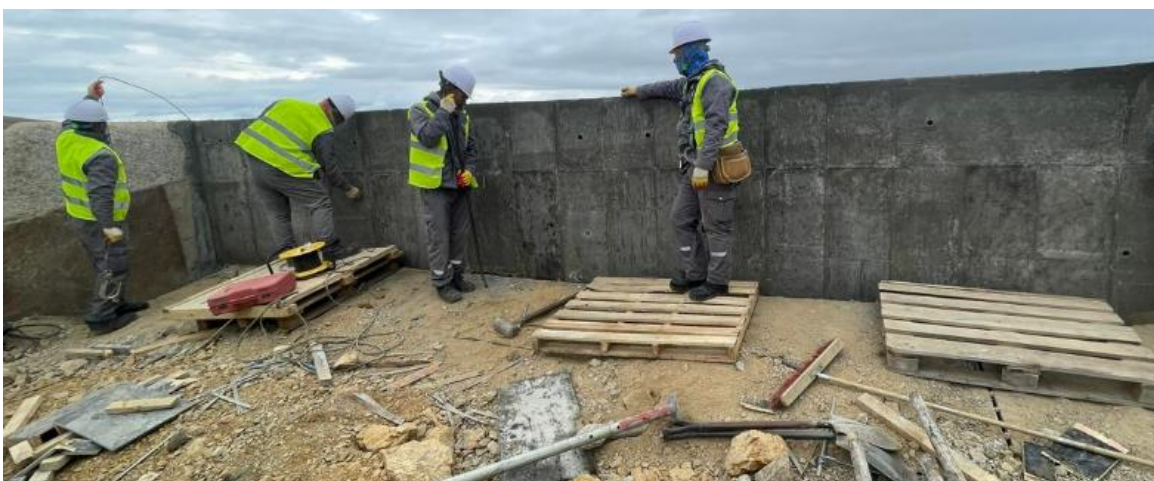
Зураг 85. Барилга байгууламжийн засвар үйлчилгээний ажил гүйцэтгэж буй байдал
