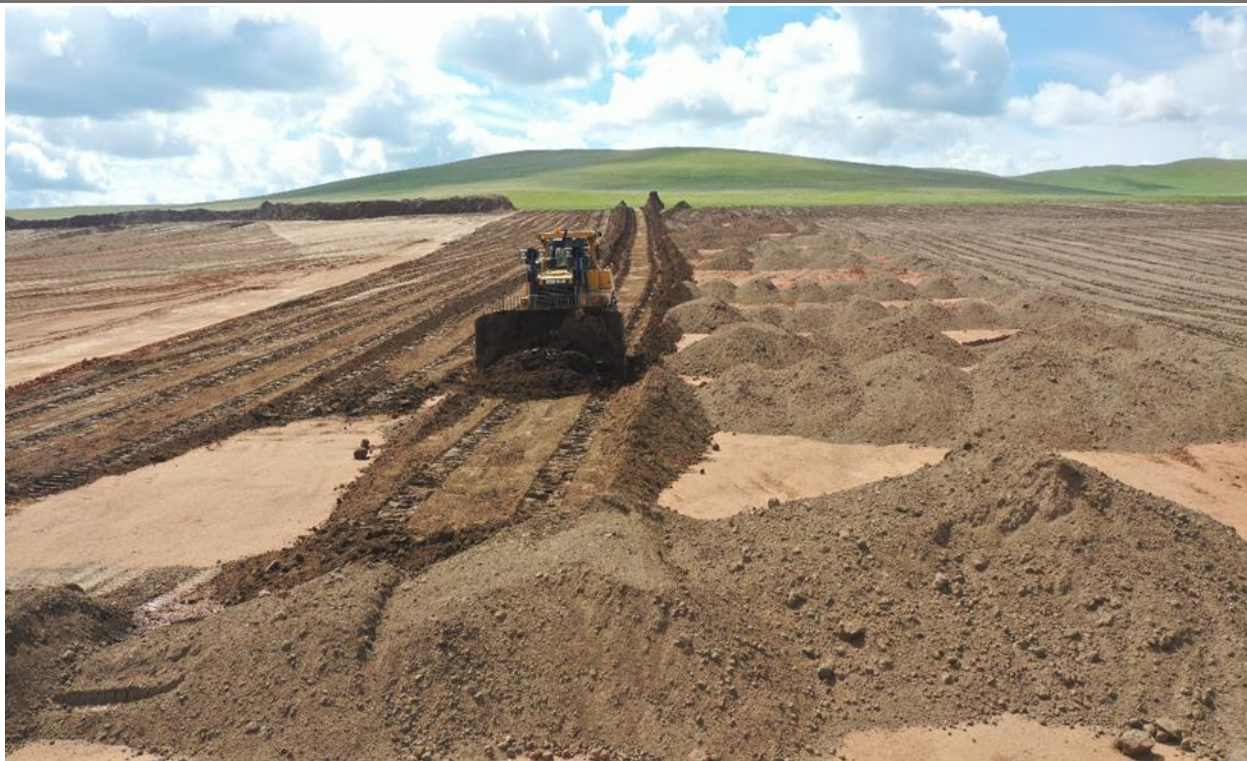
Зураг 30. Их Дашир Үндсэн Хөндий Адаг талбайг шимт хөрсөөр хучиж буй байдал
