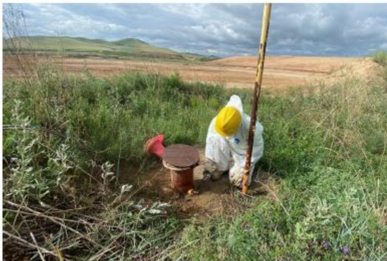
Зураг 11. Суултын болон хамгаалалтын янданг тайрч буй байдал
