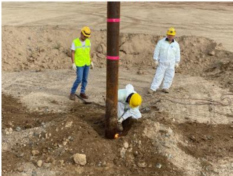
Зураг 6. Суултын болон хамгаалалтын янданг тайрч буй байдал
