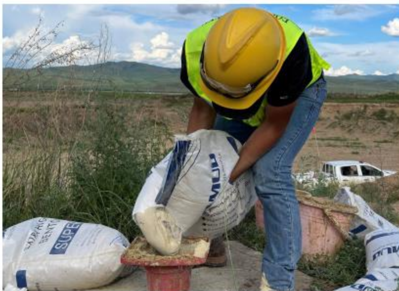
Зураг 23. Цооногт бентонит хийж буй байдал
