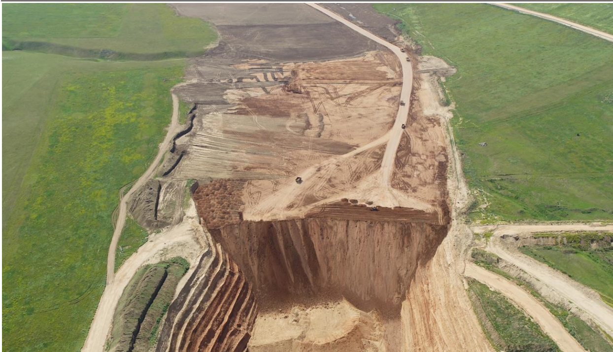
Зураг 29. Нөхөн дүүргэлт хийгдэж буй байдал
