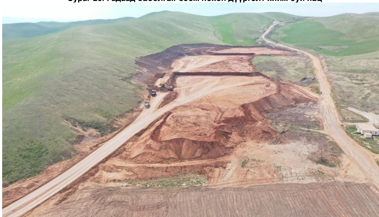
Зураг 27. Гадаад овоолгыг зөөж нөхөн дүүргэлт хийж буй явц /2022.05.01-ны байдлаар/
