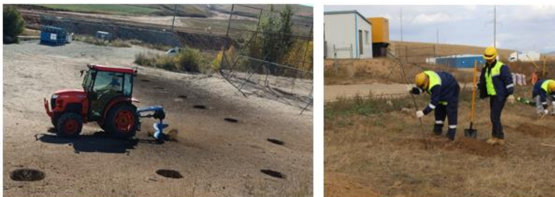
Зураг 46. Нүх ухагч трактороор бэлтгэсэн модны нүх, хөрс сийрүүлж бэлтгэх ажил
