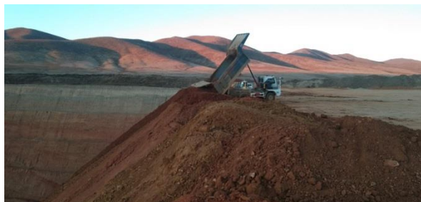
Зураг 19, 20. Карьерт дүүргэлт хийж техникийн нөхөн сэргээлт хийж байгаа байдал
