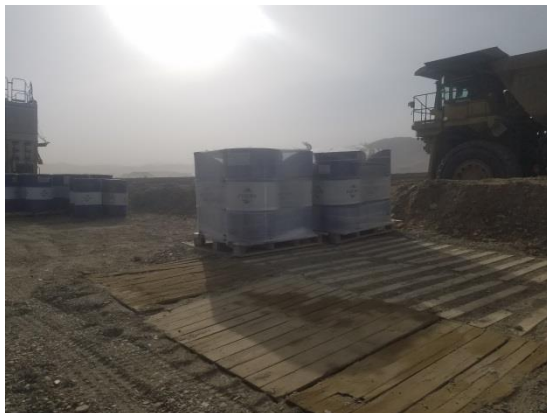
Зураг 10. ШТС-ийн шимт хөрсийг авч, эйфел дэвсэж, тусгаарлалт хийсэн байдал.
