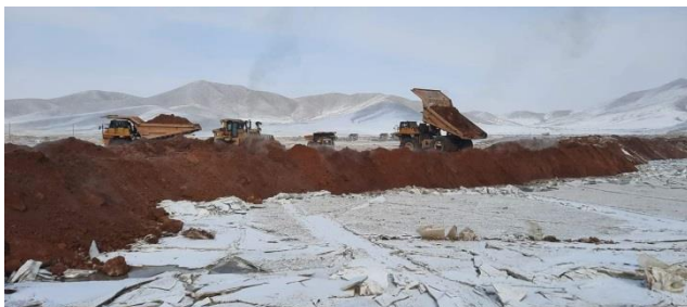
Зураг 19, 20. Карьерт дүүргэлт хийж техникийн нөхөн сэргээлт хийж байгаа байдал
