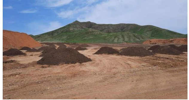
Зураг 21, 22 . Шимт хөрс ачиж буулгах, талбайд тарааж тэгшилэх ажлын үйл явц
