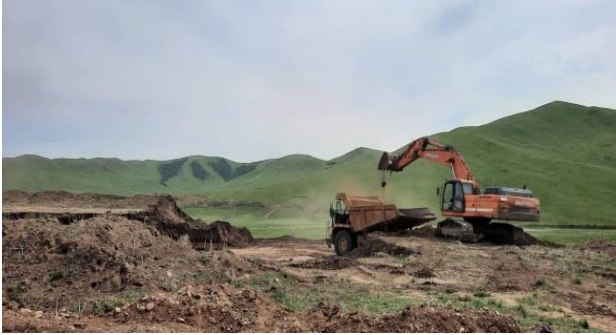
Зураг 21, 22 . Шимт хөрс ачиж буулгах, талбайд тарааж тэгшилэх ажлын үйл явц
