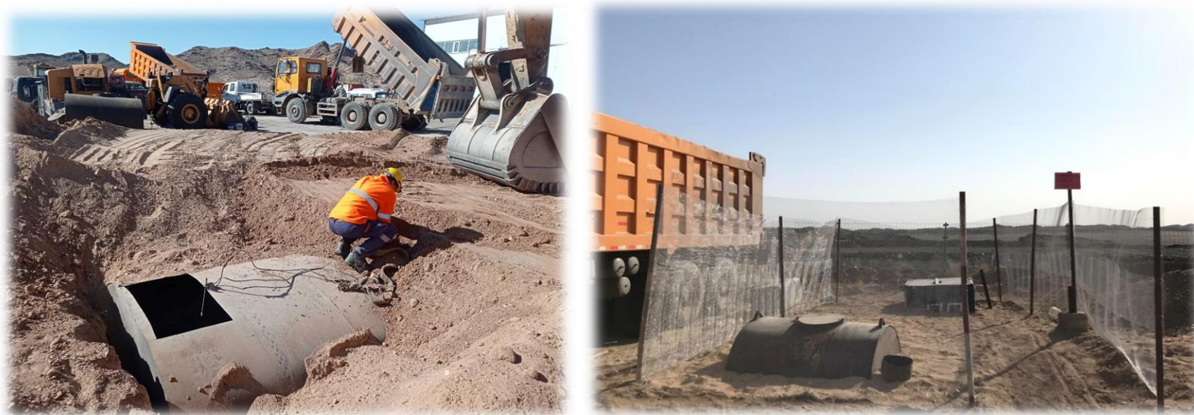
Зураг 27. ШТМ хадгалах 10 тонн болон 3тоннын битүүмжилсэн савыг нэмэлтээр байршуулах ажлын явцэ
