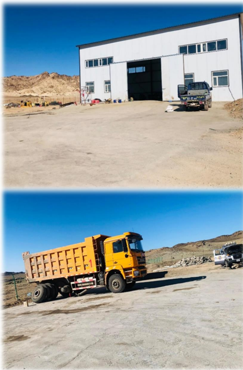
Зураг 23. Засвар үйлчилгээний төвийн урд 600 м 2 талбайг бетондсон байдал.
