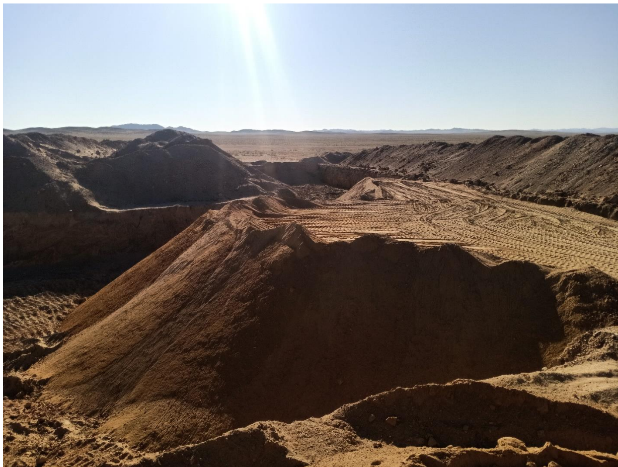
Зураг-4: Дотоод овоолгоор техникийн нөхөн сэргээлт хийж буй байдал.
