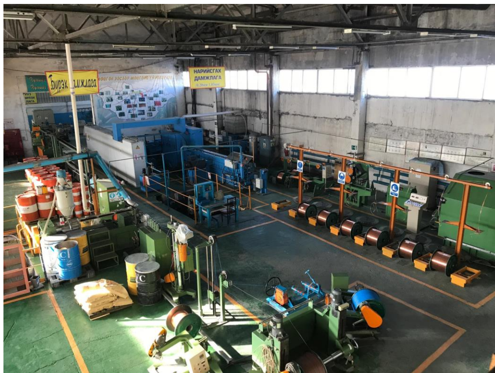
Зэс утасны үйлдвэр цех дотор
