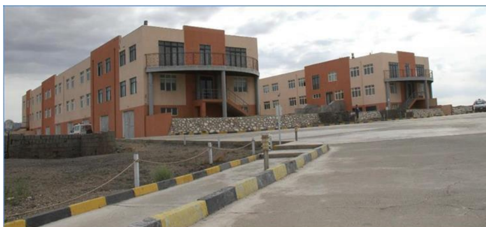
Зураг 2. Ажилтнуудын амрах байр
