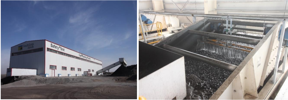
Зураг 12. Нүүрсийг нойтон технологиор баяжуулах үйлдвэр
