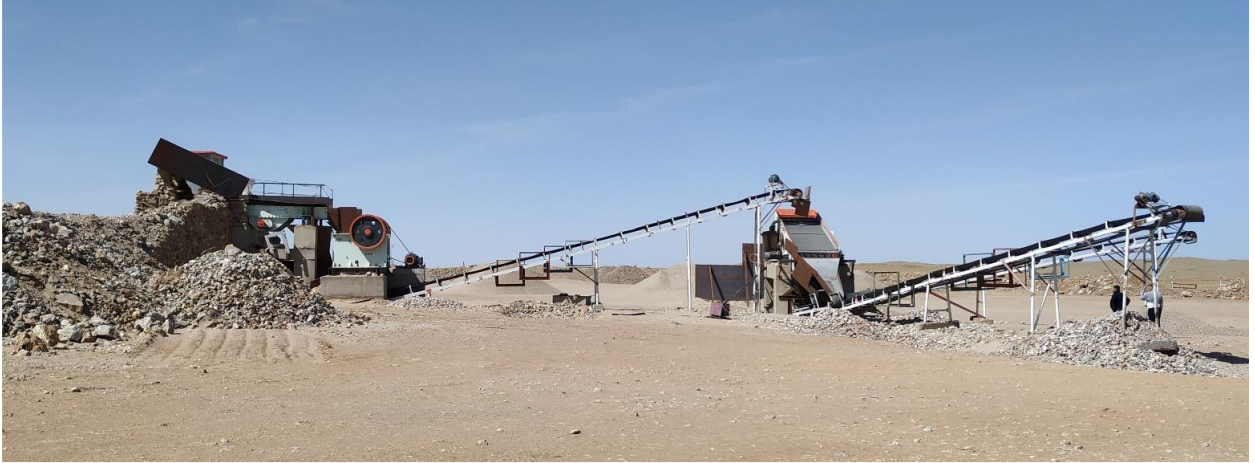
Зураг 4. Баяжуулах үйлдвэрийн тоног төхөөрөмж
