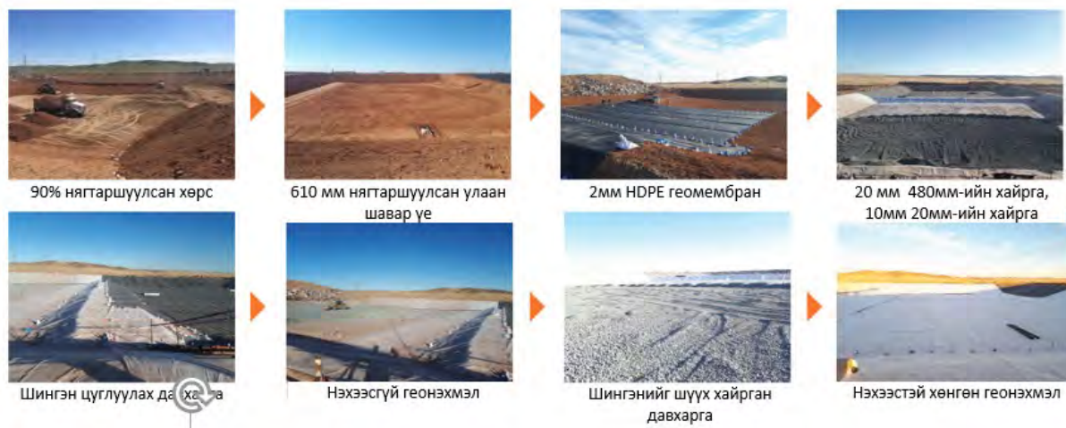
Зураг 13. Хог хаягдал булшлах байгууламжийн суурь үеүүд
