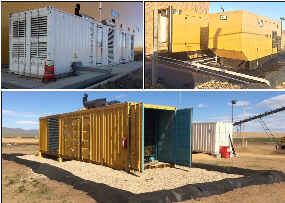
Зураг 7. Төслийн цахилгаан эх үүсвэрийн дизель генератор
