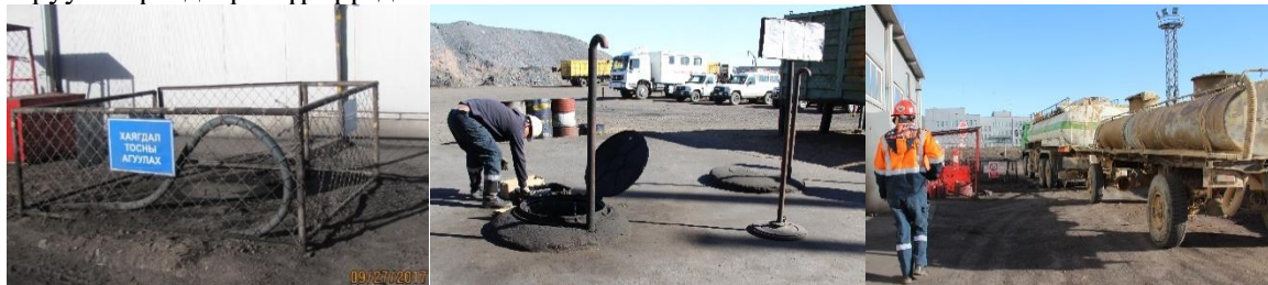
Зураг 10.2.2. Засварын төвүүдийн хаягдал тос цуглуулах танкнуу
