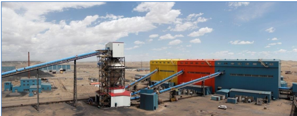
Зураг 1.2. Нүүрс баяжуулах үйлдвэр
