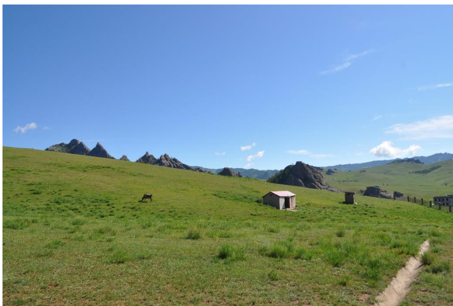
Зураг.3. Бохир ус цэвэршүүлэх байгууламжийн зураг
