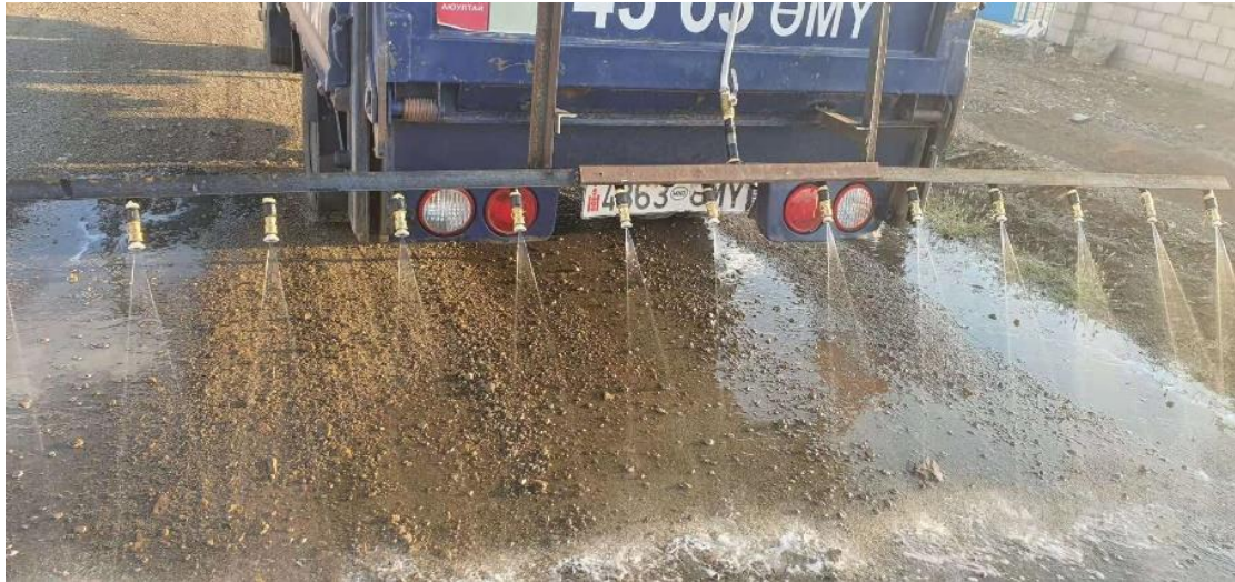
Зураг 3-2. Замын усалгаа чийгшүүлэлтээр тоос дарах үйл явц
