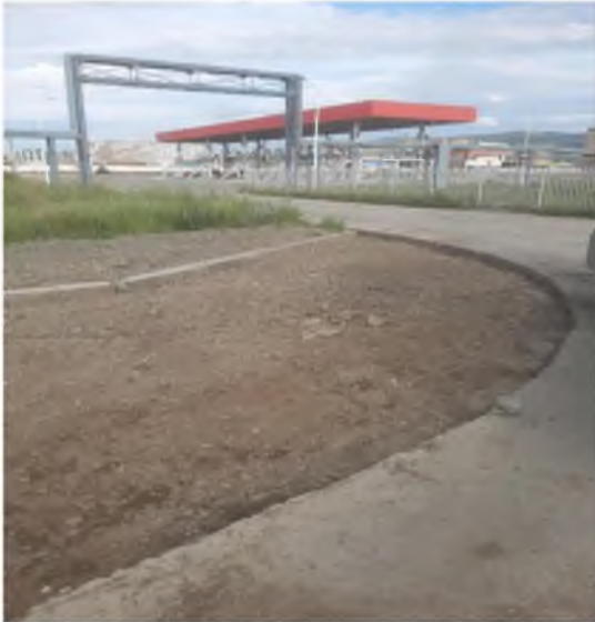
Зураг. 2 Резирвуаруудын дундах галын зам, талбайг өргөсгөж ,бетонон хучилт хийсэн байдал
