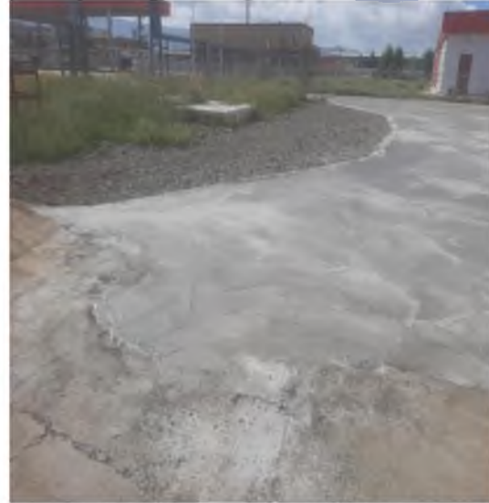
Зураг. 2 Резирвуаруудын дундах галын зам, талбайг өргөсгөж ,бетонон хучилт хийсэн байдал
