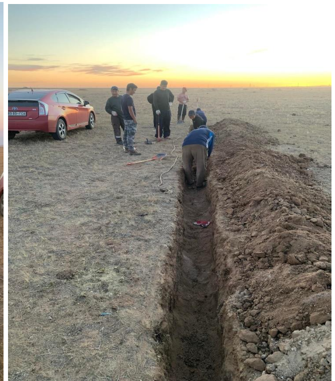
1.5 Агуулахын гадна талаас хойш 300 метрийн зайтай 50/50 см, гүн өргөнтэй 1,2 км газари ой хээрийн түймэр болон үер усны аюул байгалийн гамшигт үзэгдлээс сэргийлж далан шуудуйг ухаж бий болголоо.
