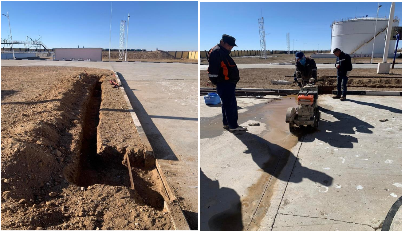
1.4 2-р агуулахын Автоцистерн ачиж, буулгах талбай дээр шатахуун асгарсан тохиолдолд шатахуун цуглуулах трапыг трапыг хийж гүйцэтгэлээ.
