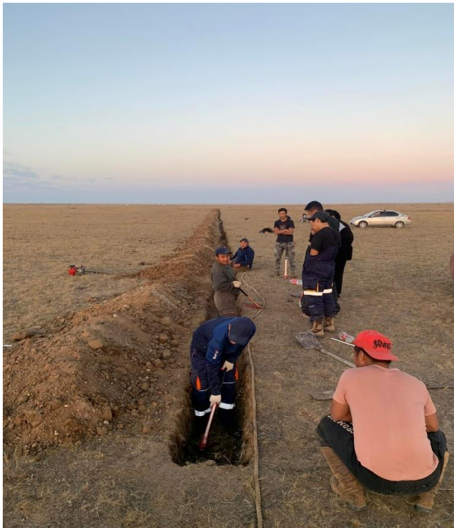
1.5 Агуулахын гадна талаас хойш 300 метрийн зайтай 50/50 см, гүн өргөнтэй 1,2 км газари ой хээрийн түймэр болон үер усны аюул байгалийн гамшигт үзэгдлээс сэргийлж далан шуудуйг ухаж бий болголоо.
