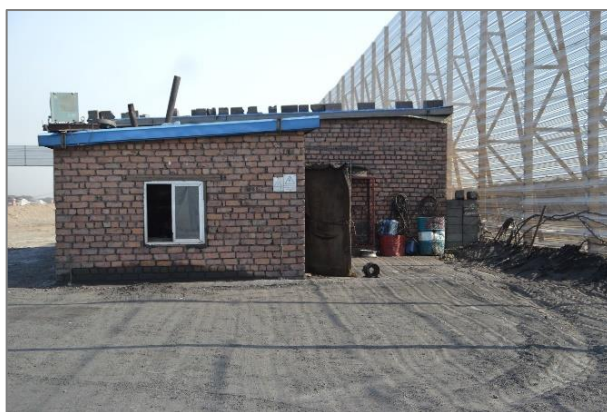
Зураг 1-9. Цахилгааны эх үүсвэрийн байр
