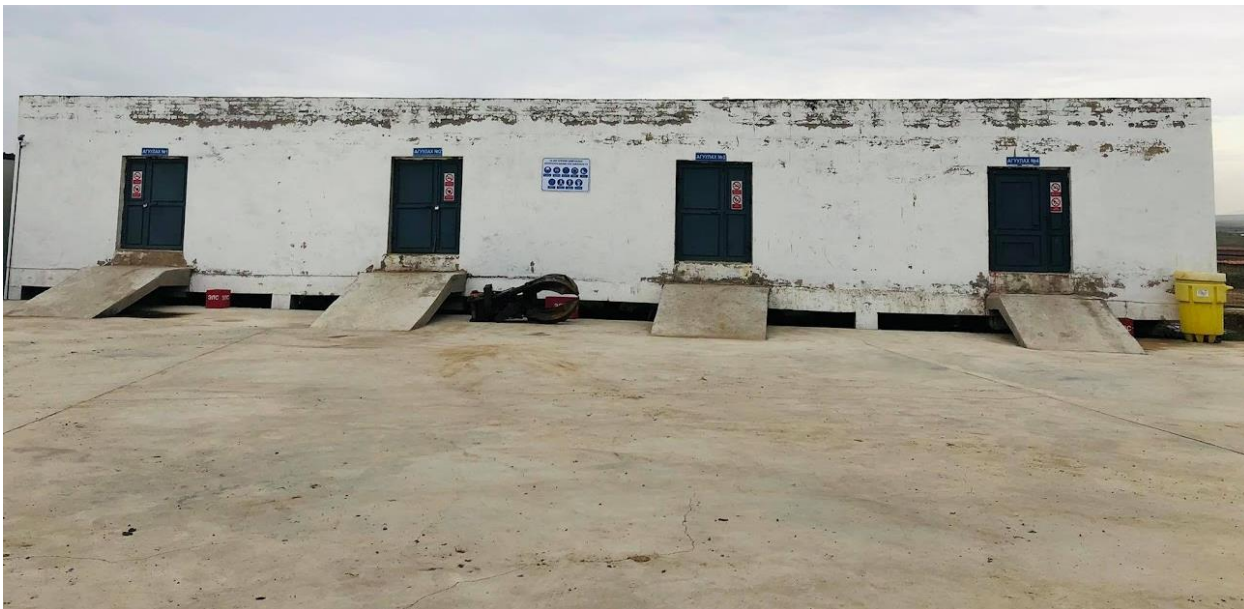
Зураг 5. Химийн бодис хадгалах, аюултай хог хаягдал хүлээн авах хэсгийг бүрэн бетондож цементжүүлсэн.
