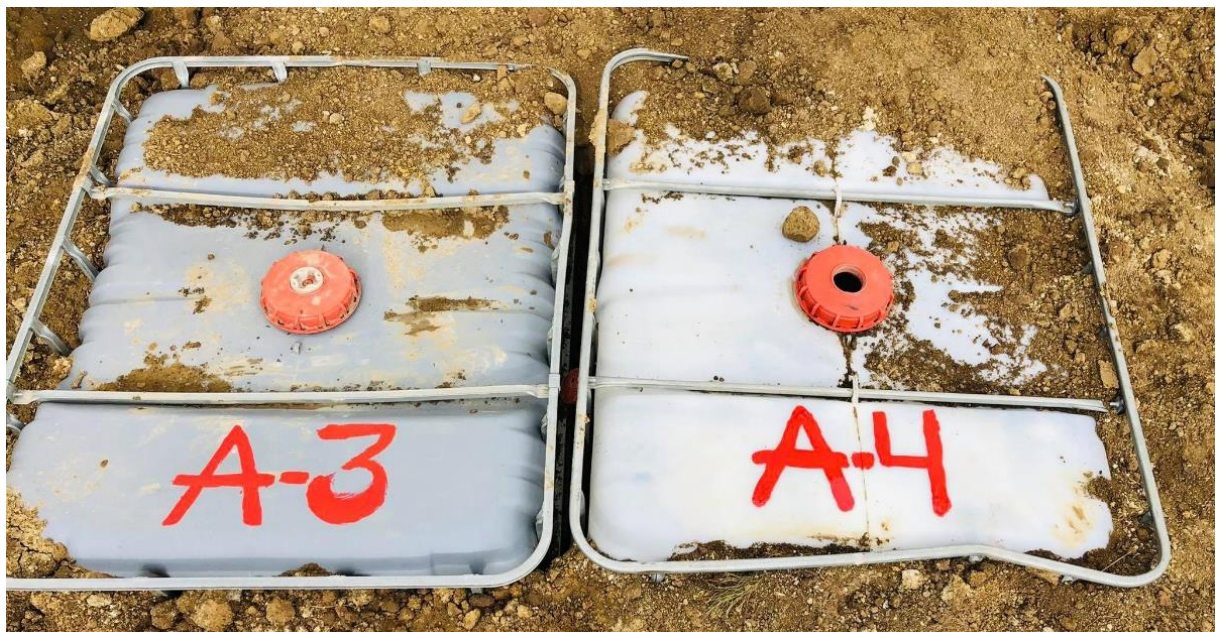
Зураг 34. Эрүүл мэндийн байгууллагын хог хаягдлын төвийн химийн бодисын агуулахын асгаралт цуглуулах танк
