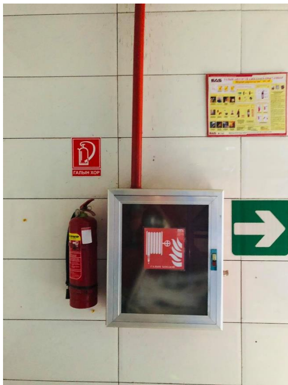
Зураг 29. Эрүүл мэндийн байгууллагын хог хаягдлын төвийн химийн бодисын агуулахад галын гор, галын хортой ажиллах заавар байршуулсан байдал
