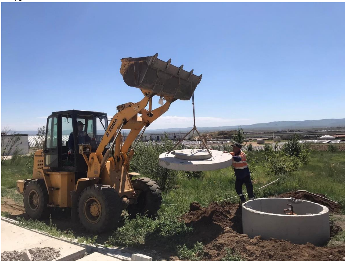
Зураг 28. Газрын доорх усны мониторингийн цооног байгуулж буй фото зураг №1
