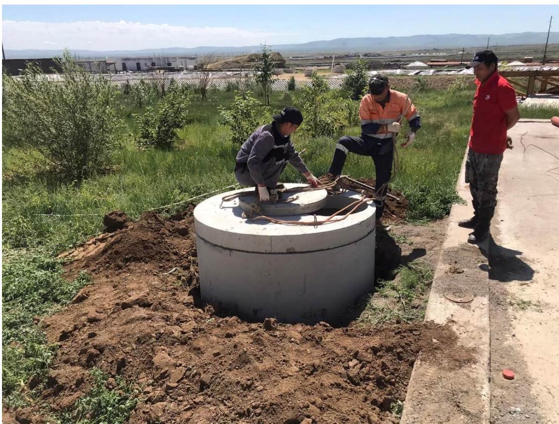
Зураг 29. Газрын доорх усны мониторингийн цооног байгуулж буй фото зураг №2
