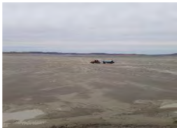
РВ-80100 тоног төхөөрөмжөөр кальцийн хлорид цацаж байгаа байдал
