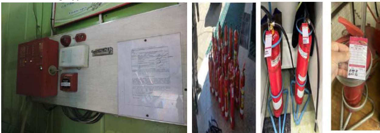
Зураг 106, 107. Гал унтраах автомат систем, анхан шатны багаж хэрэгсэл
