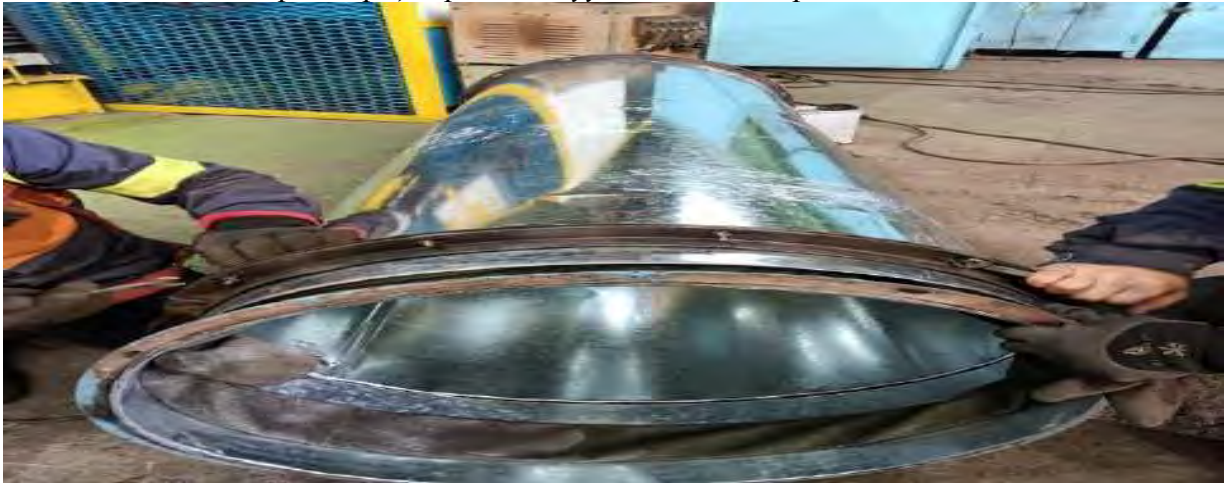
Бохир агаар цэвэрлэх байгууламжид засвар хийсэн байдал:
