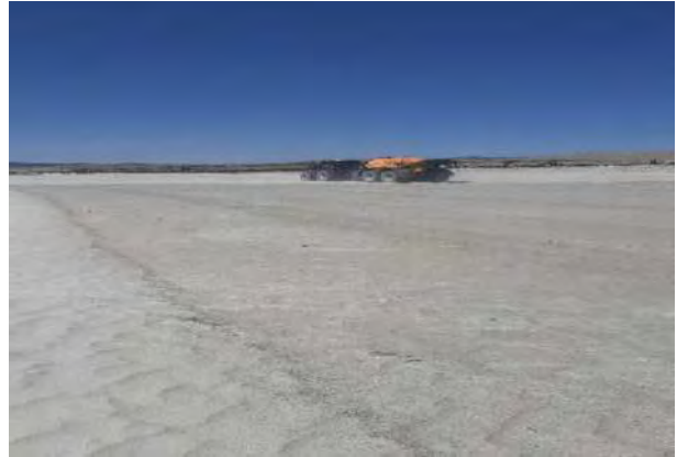
РВ-80100 тоног төхөөрөмжөөр кальцийн хлорид цацаж байгаа байдал
