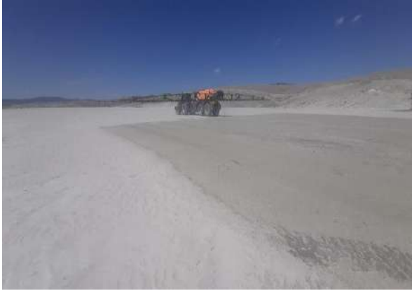
РВ-80100 тоног төхөөрөмжөөр кальцийн хлорид цацаж байгаа байдал
