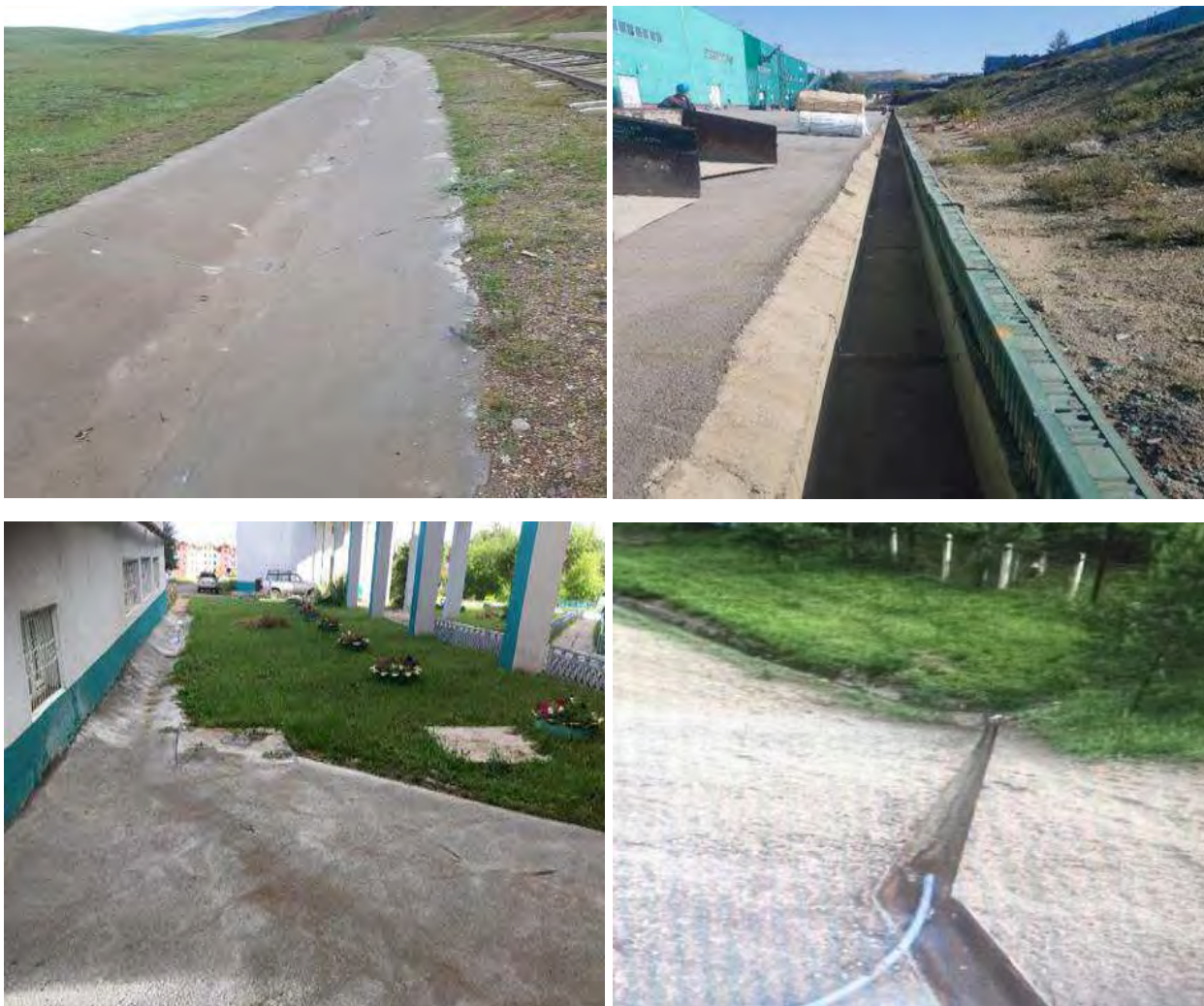
Зураг 59. Үерийн усны суваг, шуудууг засварласан байдал
