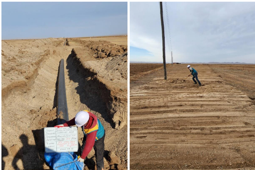
Зураг 15. Газар шорооны ажлын үед үүсгэсэн ухаш, овоолгыг тэгшилж, анхны төрхөнд нь оруулах буюу техникийн нөхөн сэргээлт хийж буй байдал
