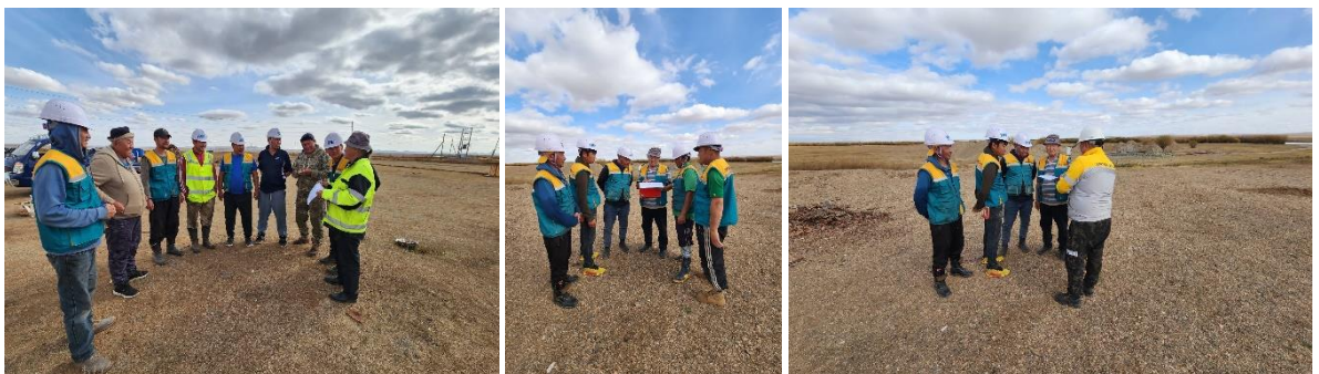
Зураг 32. Ажлын талбай дээр ХАБЭА-н зааварчилгаа өгч буй байдал
