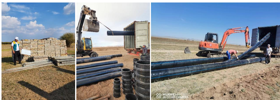
Зураг 17. Барилгажих талбайн ойролцоо нэг цэгт зарим материалыг буулгаж буй байдал
