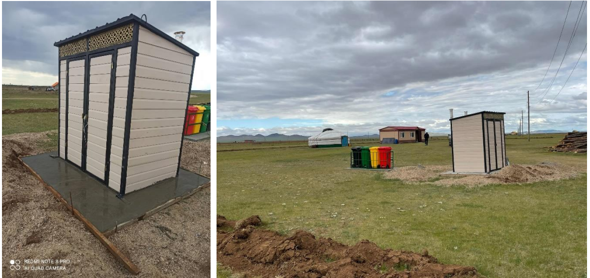
Зураг 40. Хөрснөөс тусгаарласан ариун цэврийн байгууламж байгуулсан байдал
