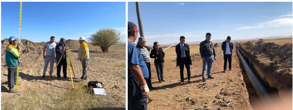
Зураг 8. Холбогдох албаны хүмүүс барилгын ажлын явцтай танилцаж, хяналт тавьж буй байдал
