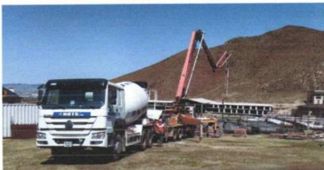
Зураг 26. Бетоныг барилгын талбайд буулгаж буй байдал
