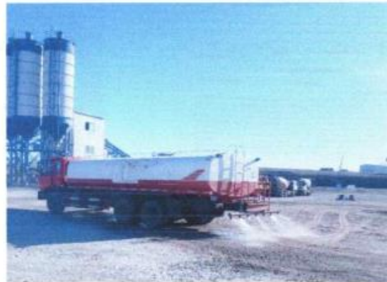
Зураг 3.1 Үйлдвэрийн хашаан доторх шороон замыг дагтаршуулсан байдал
