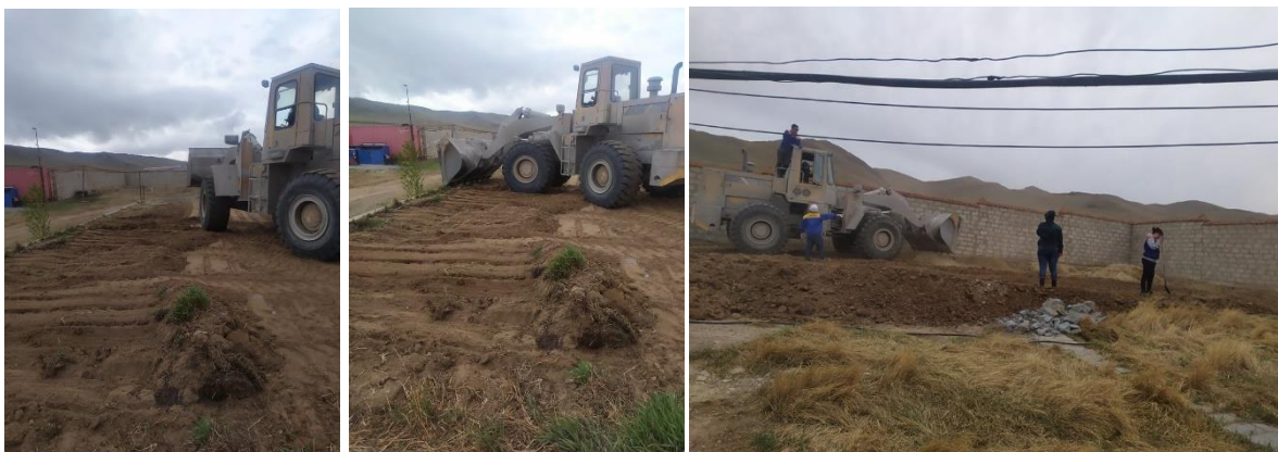
Зураг 28. Биологийн нөхөн сэргээлт хийхээр төлөвлөсөн талбайд техник ашиглан хөрс бэлтгэж буй байдал
