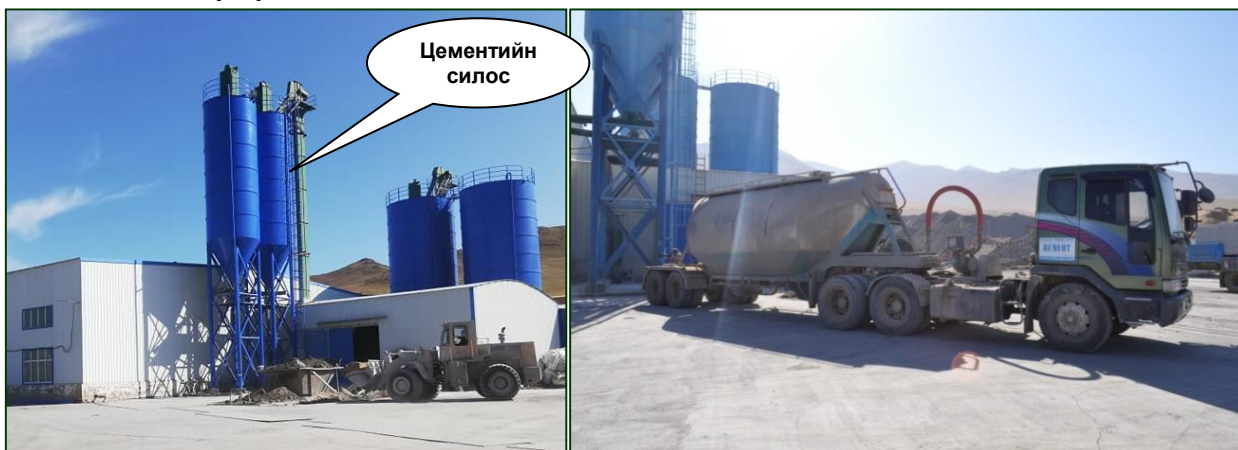
Зураг 5. Цементийн силос буюу силосд цемент шахаж буй байдал
