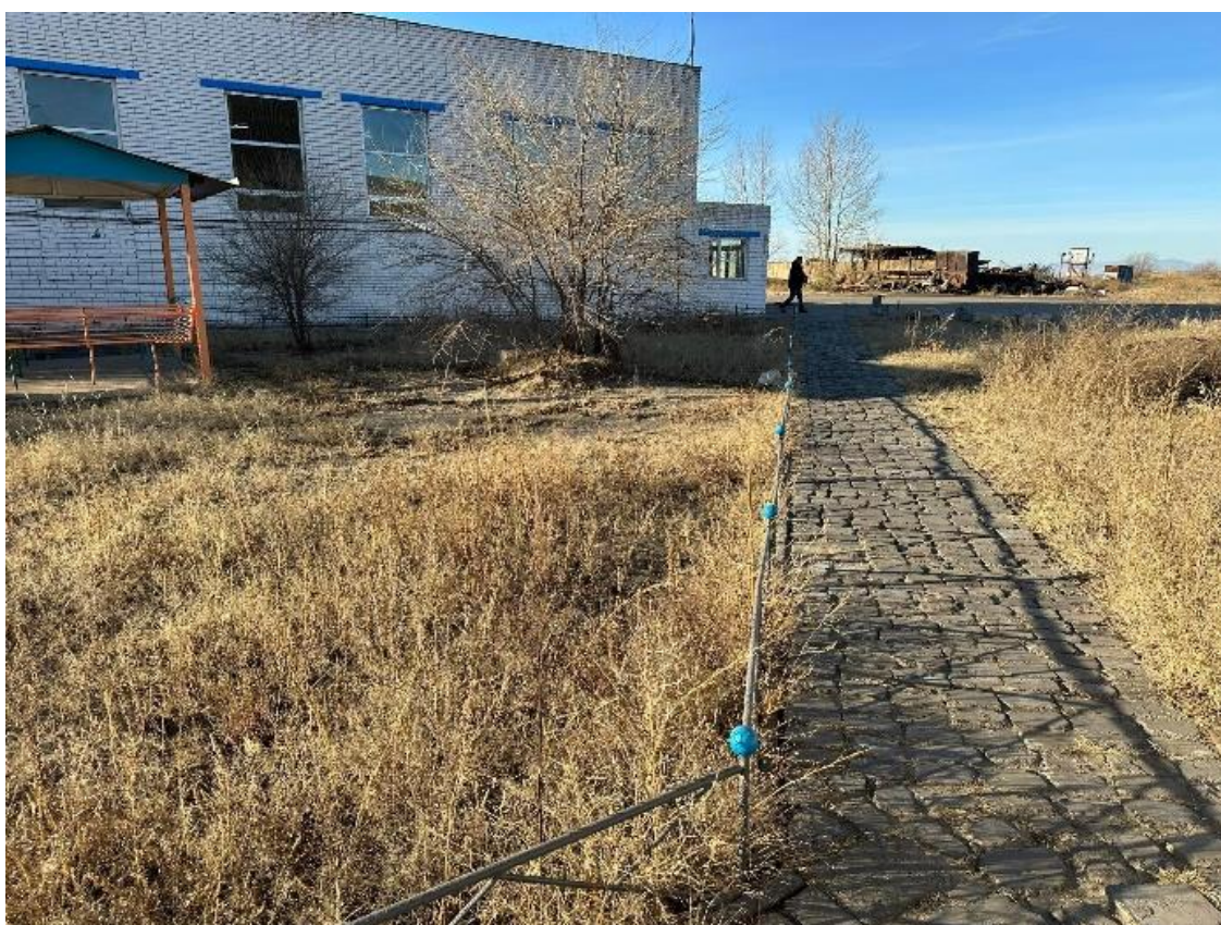
Зураг 10 Үйлдвэр шугам сүлжээний хашиан дотор хаягдал тоосго ашиглан явган зам хийсэн байдал
