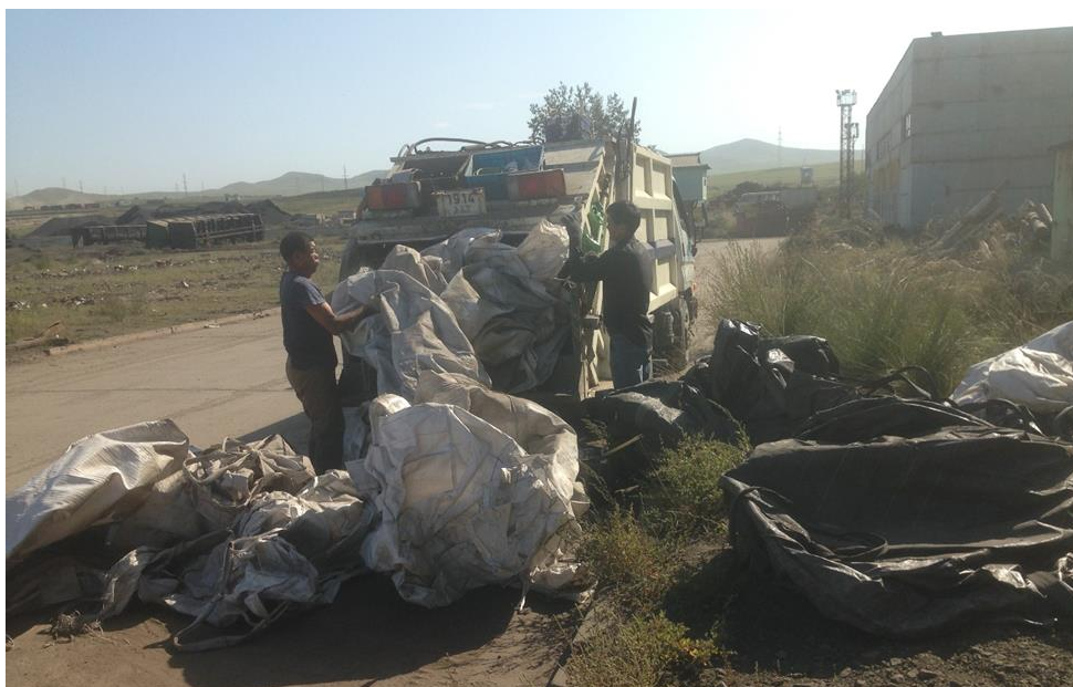
Зураг 17 Хатуу хог хаягдал ачуулж буй байдал
