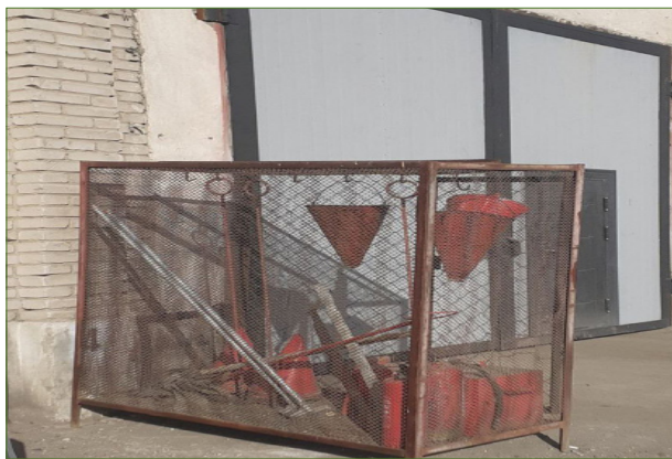
Зураг 31. Галын аюулгүй байдлын тоног төхөөрөмж
