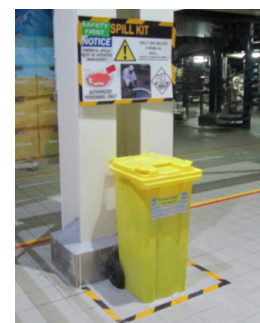
Зураг 25. Шингэн бодис асгарсан тохиолдолд хурааж авах суурь сав, шингээгч материал
