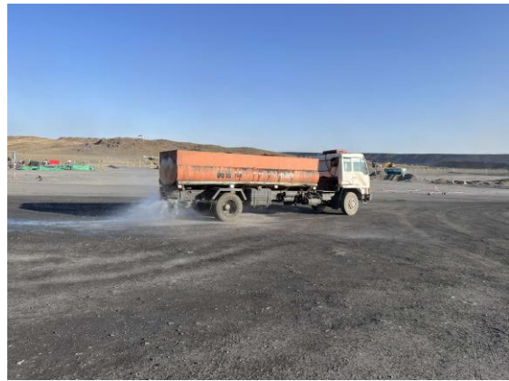
Зураг 2.1, 2.2 Түр замын усалгаа, түр замын засвар арчилгаа хийж буй байдал
