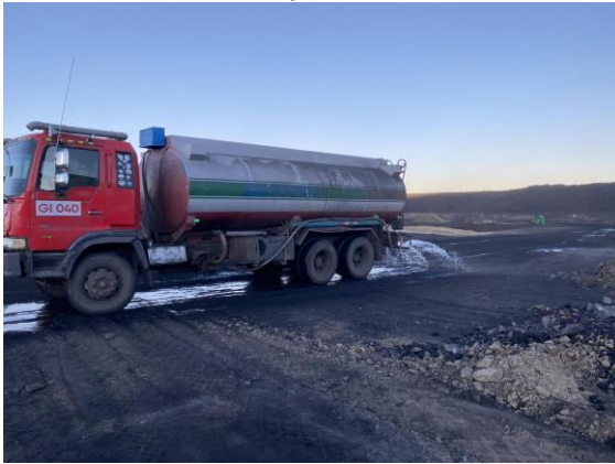
Зураг 2.1, 2.2 Түр замын усалгаа, түр замын засвар арчилгаа хийж буй байдал
