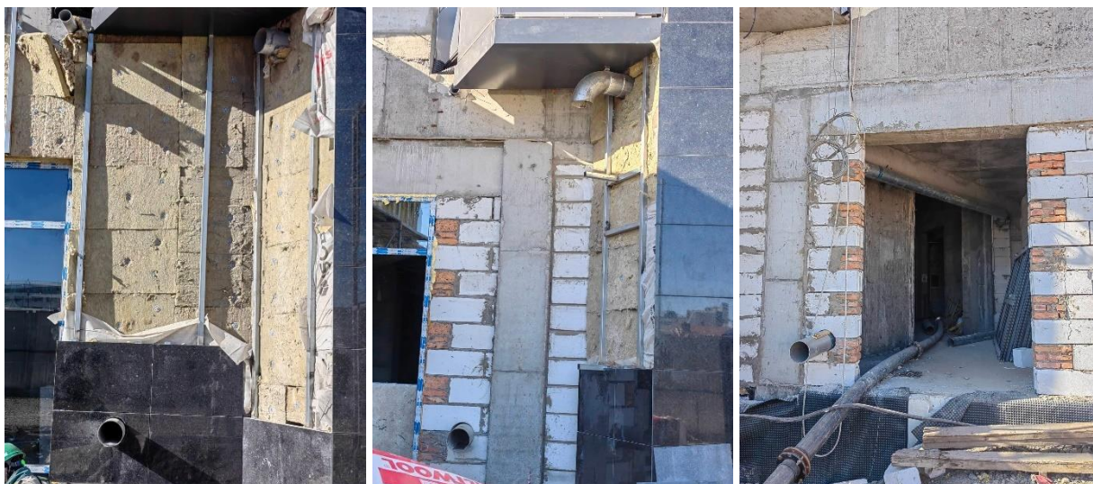
Зураг 14. Борооны ус зайлуулах хоолойг холболт хийж суурилуулсан байдал
