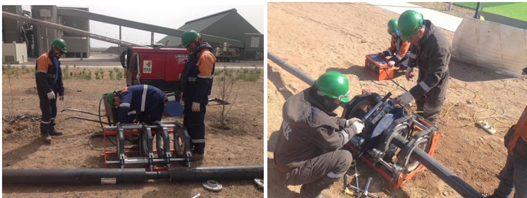
Зураг 13. Шугам сүлжээний засвар, угсралтын ажил гүйцэтгэж байгаа нь
