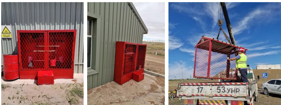
Зураг 36. Галын сарайнуудыг шинэчилсэн байдал
