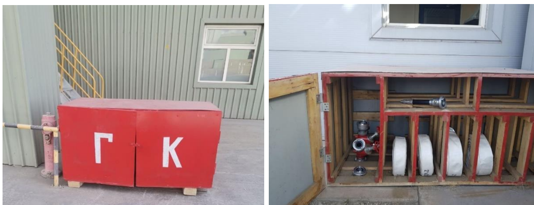
Зураг 37. Галын гидрантуудын ажиллагааг шалгаж бүрэн бүтэн байдлыг хангасан
