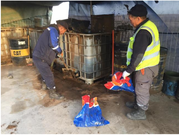
Зураг 8-1. Саармагжуулах талбай байгуулан, тосоор бохирдсон хөрсийг тус талбайд байргуулан саармагжуулж байна.
