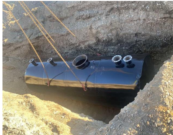
Зураг 4-12 Инженерийн түр оффисын бохир цуглуулах танканд шингэн нэвчүүлэх сорил хийж буй болон танк суурилуулж буй байдал, 2022.10.13
