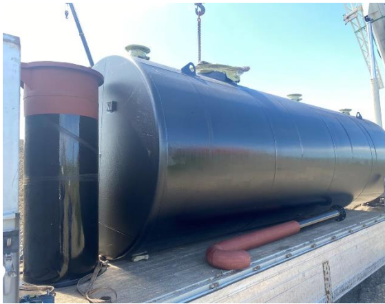
Зураг 4-12 Инженерийн түр оффисын бохир цуглуулах танканд шингэн нэвчүүлэх сорил хийж буй болон танк суурилуулж буй байдал, 2022.10.13
