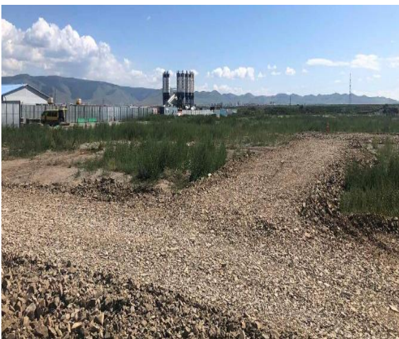
Зураг 4-8 Төслийн талбайн түр замыг тэгшилж, дайрга дэвссэн байдал
