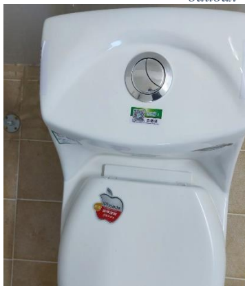
Зураг 4-14 Түүр оффист автомат цорго болон 2 сонголттой суултуур суурилуулсан байдал
