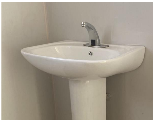
Зураг 4-14 Түүр оффист автомат цорго болон 2 сонголттой суултуур суурилуулсан байдал
