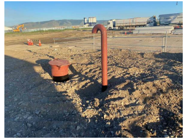
Зураг 4-12 Инженерийн түр оффисын бохир цуглуулах танканд шингэн нэвчүүлэх сорил хийж буй болон танк суурилуулж буй байдал, 2022.10.13
