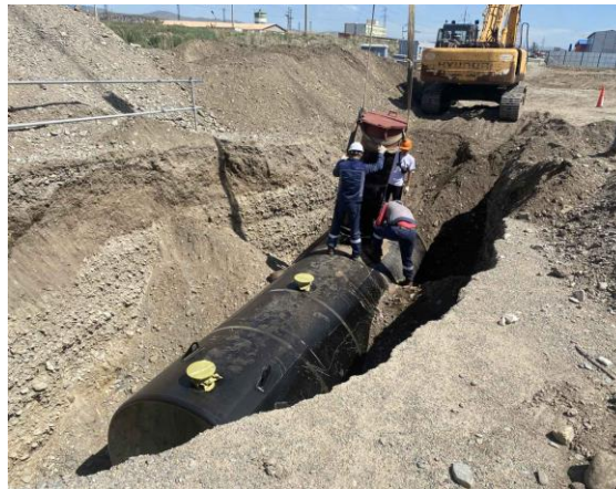
Зураг 4-12 Инженерийн түр оффисын бохир цуглуулах танканд шингэн нэвчүүлэх сорил хийж буй болон танк суурилуулж буй байдал, 2022.10.13
