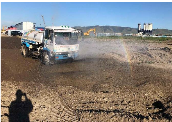
Зураг 4-8 Төслийн талбайн түр замыг тэгшилж, дайрга дэвссэн байдал
