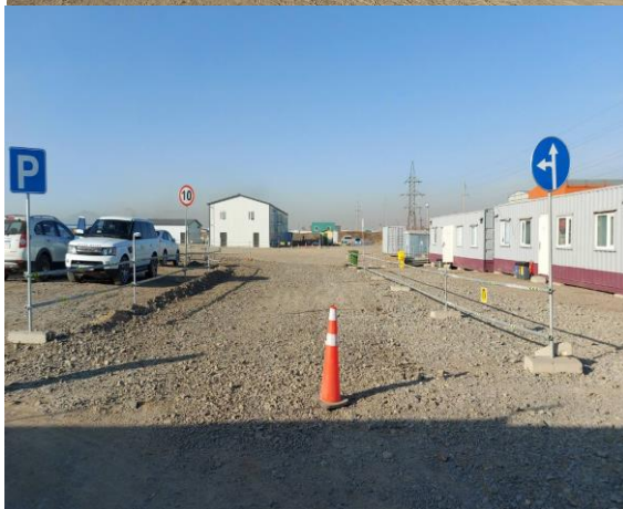
Төслийн талбайд аюул бүхий хэсгүүдийг тусгаарласан хатуу хаалт хашилт, анхааруулах мэдээлэл байршуулсан байдал болон замын тэмдэг байрлуулсан байдал
