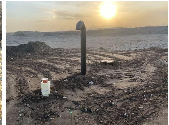
Зураг 4-12 Инженерийн түр оффисын бохир цуглуулах танканд шингэн нэвчүүлэх сорил хийж буй болон танк суурилуулж буй байдал, 2022.10.13
