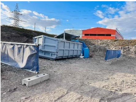
Зураг 8-5 2023 онд төслийн талбайд бий болгохоор төлөвлөж буй барилгын хаягдлын нэгдсэн хогийн цэг (Зүүн талаас: Бусад хог, Мод, Төмөр, Аюултай хаягдал)
