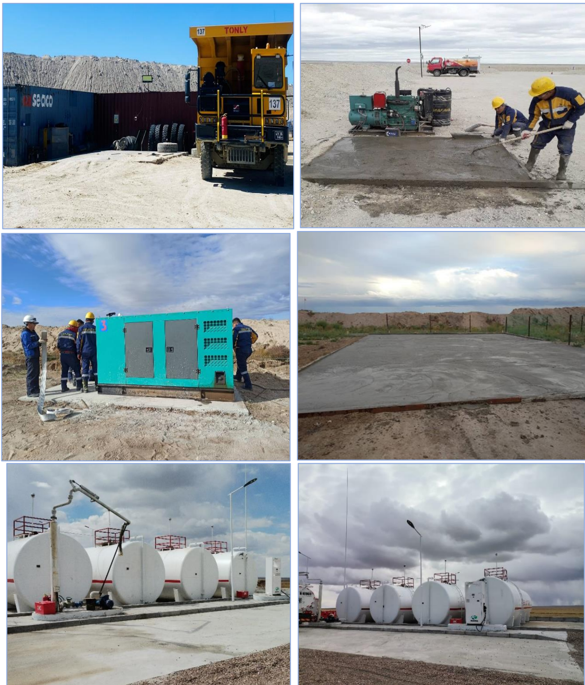
Зураг 31. Уурхайн ШТС, засвар үйлчилгээний талбай, хог хаягдлын цэг, аюултай хаягдлын талбайг хатуу хучилт хийж хөрсний бохирдлоос хамгаалсан байдал
