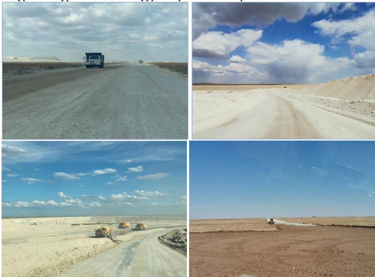
Зураг 14. Уурхайн дотоод тээврийн замд дэвсэлт болон усалгаа хийгдсэн байдал
