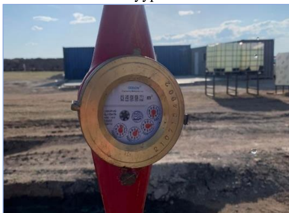
2022.04.27-ны уурхайн технологийн худгийн усны тоолуур баталгаажуулалт
