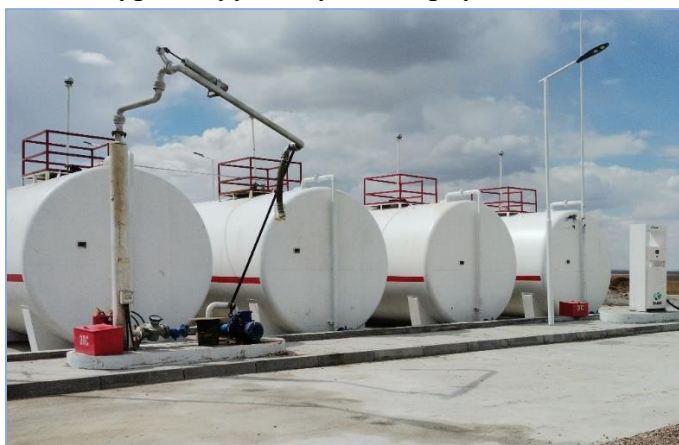
Зураг 27. Уурхайн ШТС болон цэнэглэлт хийх талбай хатуу хучилт хийгдсэн байдал
