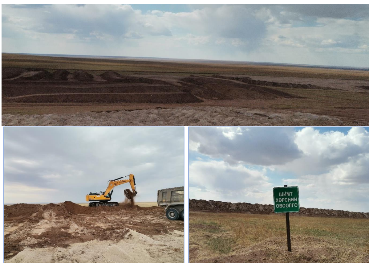
Зураг 28. Уурхайн шимт хөрсний овоолго
