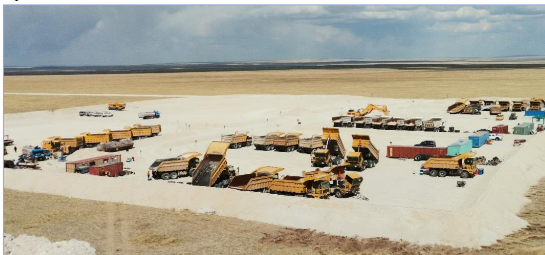
Зураг 30. Уурхайн засвар үйлчилгээний талбайнуудад хөрс хийж хамгаалсан байдал
