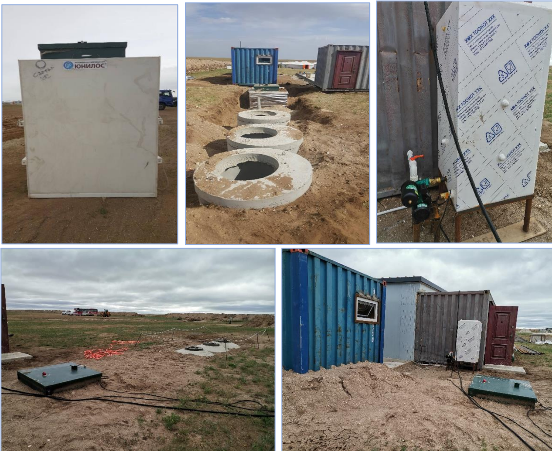
Зураг 71. “Талын ат”ХХК-н кемп дээр сууриулсан ахуйн бохир Юнинос ус цэвэрлэх байгууламж барисан байдал
