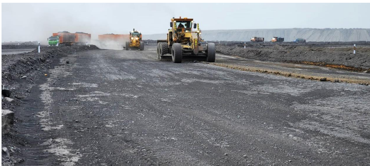
Зураг 5 Уурхайн доторх замын арчилгаа, засвар хийж буй байдал
