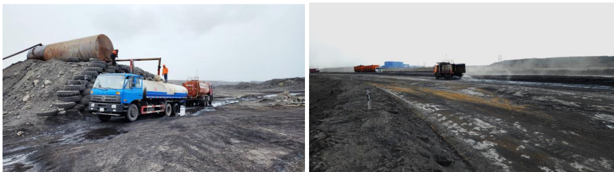
Зураг 4 Уурхайн шүүрлийн уснаас авч сайжруулсан шорооны замд усалгаа хийж буй байдал
