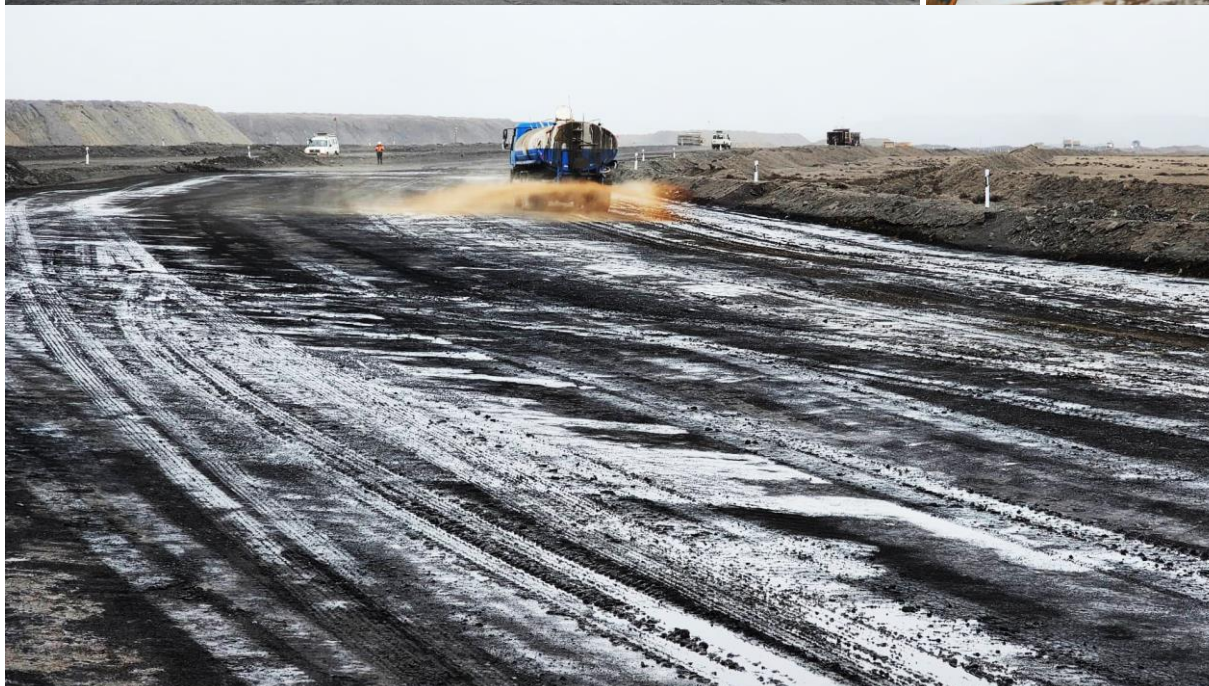
Зураг 6 Тоос дарагч бодис уурхайн зам дээр цацаж туршиж буй байдал
