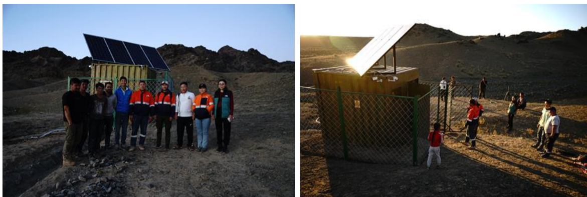
Зураг 26 Баянбор нуруунд байгуулсан уст цэгийг хүлээн авч буй байдал
