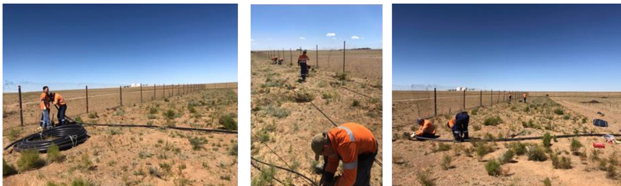
Зураг 17 Усалгааны систем угсарч буй байдал
