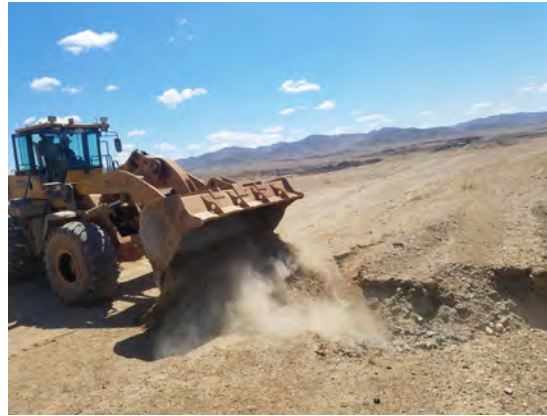
Зураг 6. Эвдэрсэн зам засаж буй байдал , зам түрсэн байдал
