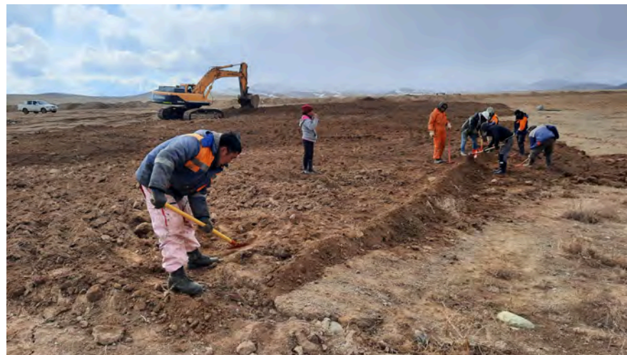
Зураг 11. Шимт хөрс хуулж авч буй байдал , 2022 оны биологи хийх талбайд шимт хөрсний овоолго хийж тараав
