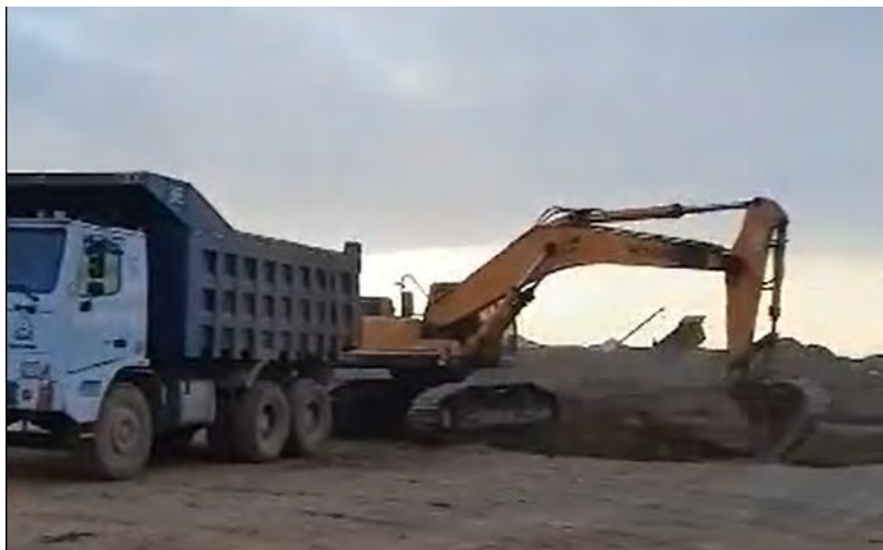
Зураг 11. Шимт хөрс хуулж авч буй байдал , 2022 оны биологи хийх талбайд шимт хөрсний овоолго хийж тараав
