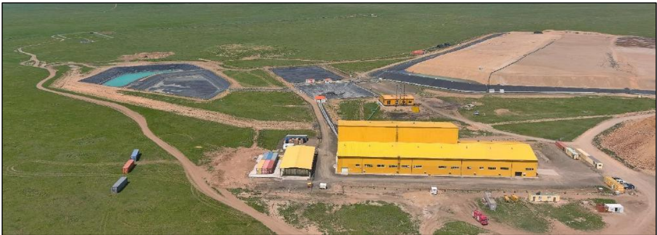
Зураг 9. Баяжуулах үйлдвэрийн барилга
