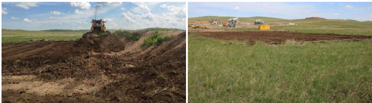
Зураг 25. Хөмсөг хэлбэрээр байрлуулсан байсан шимт хөрсийг түрж, эвдэрсэн талбайг хучиж дууссан байдал
