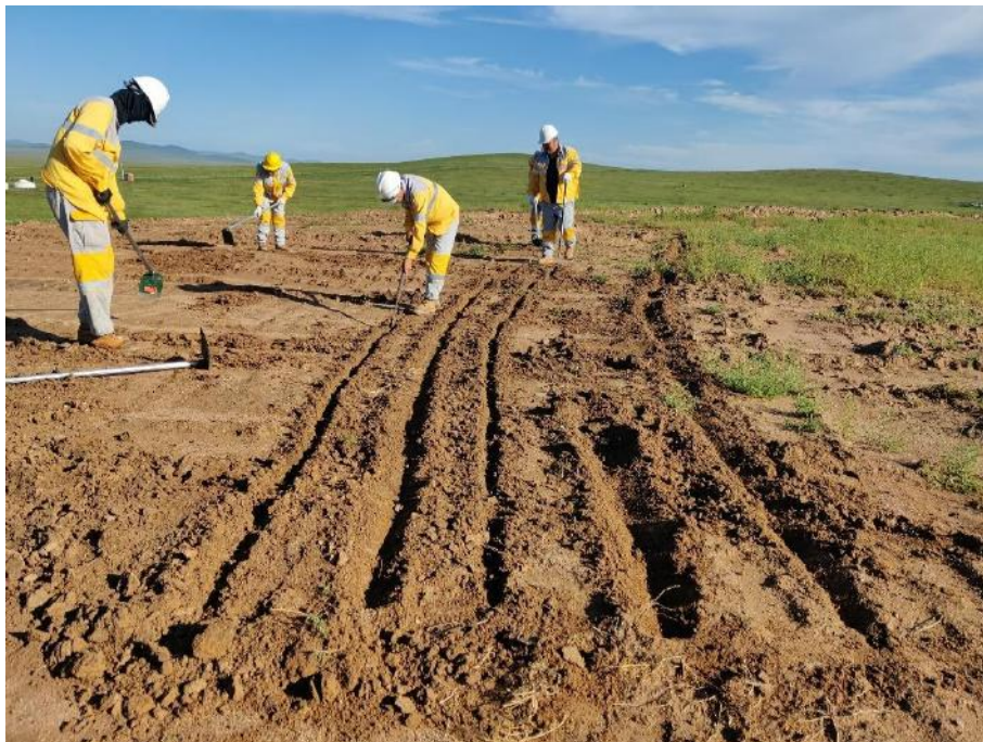
Зураг 34. Хэлбэржүүлсэн шимт хөрсний овоолго #1 дээр гар багажаар шан татаж буй байдал
