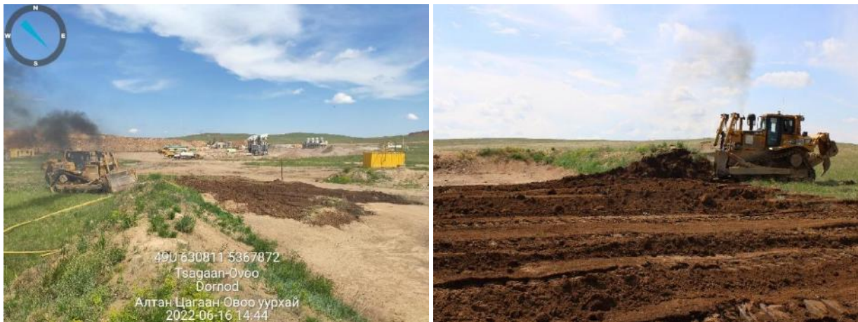
Зураг 24. Хөмсөг хэлбэрээр байрлуулсан байсан шимт хөрсийг түрж, эвдэрсэн талбайг хучиж буй байдал
