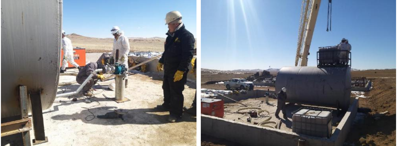
Зураг 50. Ашигласан тос, тосолгооны материал түр хадгалах ёмкост байрлуулж, насос холбож буй байдал
