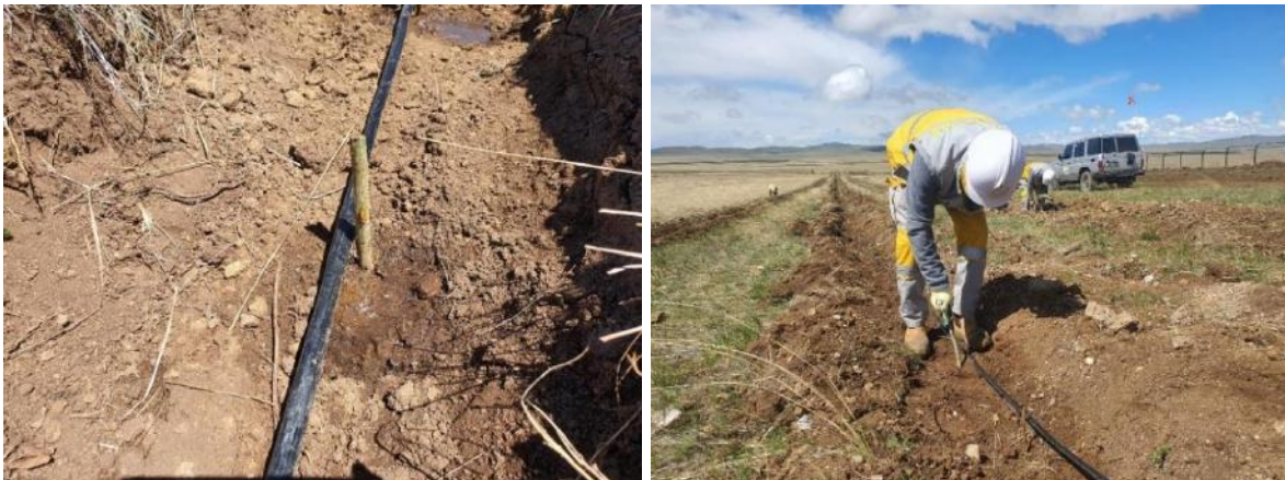
Зураг 21. Хамгаалалтын ойн зурвасын шуудуунд дуслын усалгааны систем холбосон байдал
