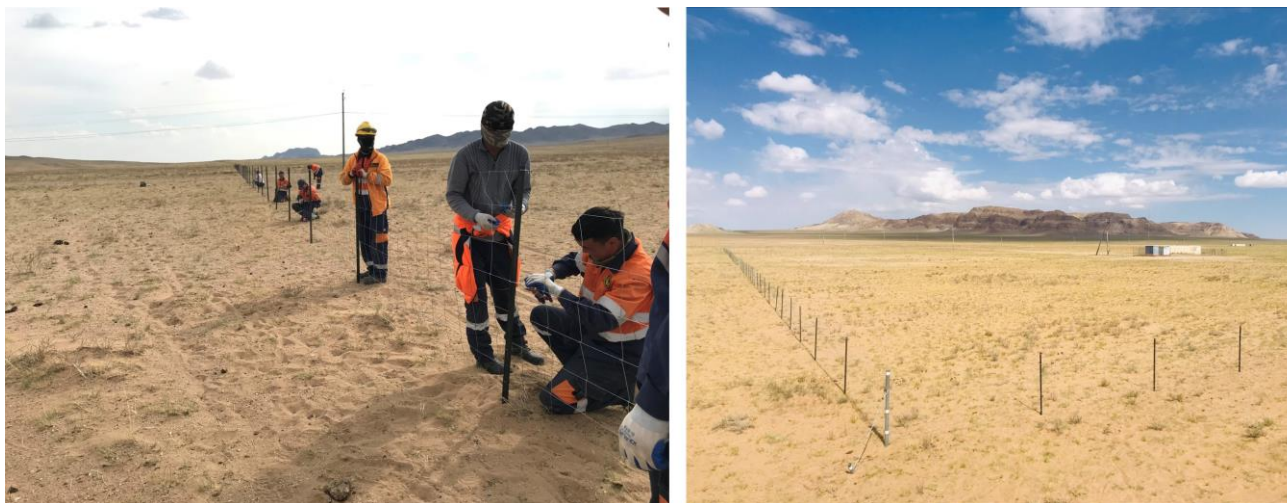
Ашиглалтын 3 дугаар худгад хамгаалалтын хашаа бариж буй байдал
