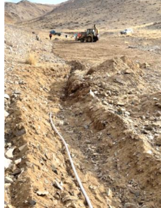
Газар доор үүсгэсэн ус хуримтлуулах сул орон зайд байрлуулах 80 литрийн багтаамжтай, нүхэлж шүүрлэсэн PVC сав
