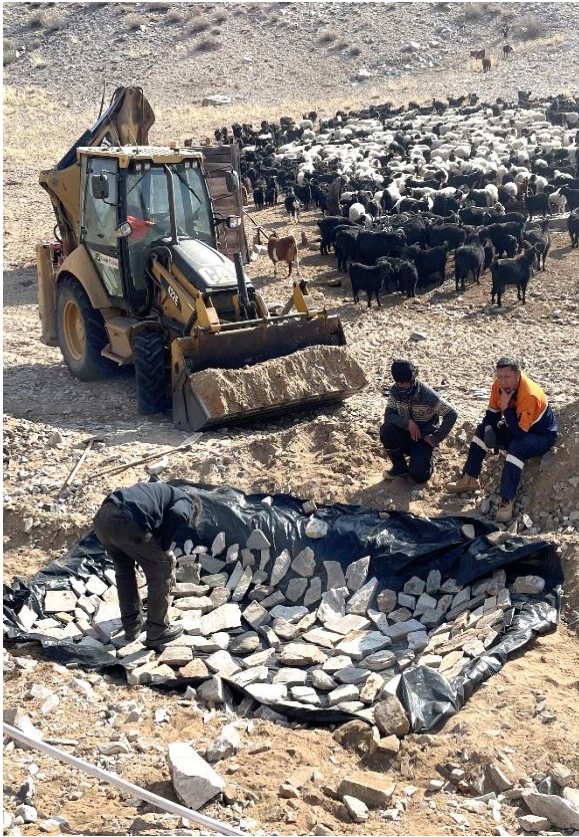
Ус нөөцлөх бетонон хөв, цөөрөмхийж байна (эзлхүүн нь 1.5 м3)
