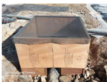
Уусмал цуглуулах хайрцаг сэргээн засварлах ажил хийгдсэн
