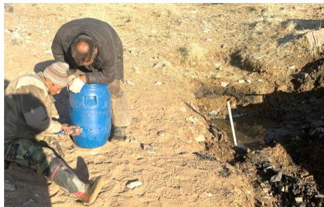
Газар доор үүсгэсэн ус хуримтлуулах сул орон зайд байрлуулах 80 литрийн багтаамжтай, нүхэлж шүүрлэсэн PVC сав
