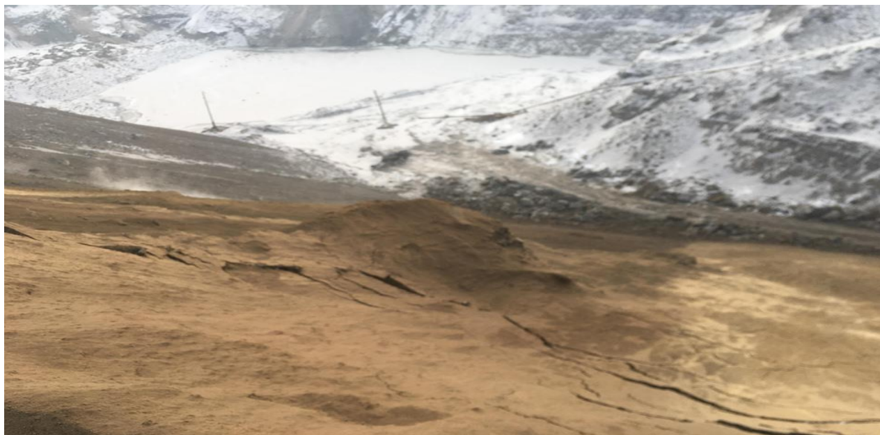
Зураг 5. Шаталт үүссэн талбайг хөрсөөр хучилт хийж унтраасан байдал
