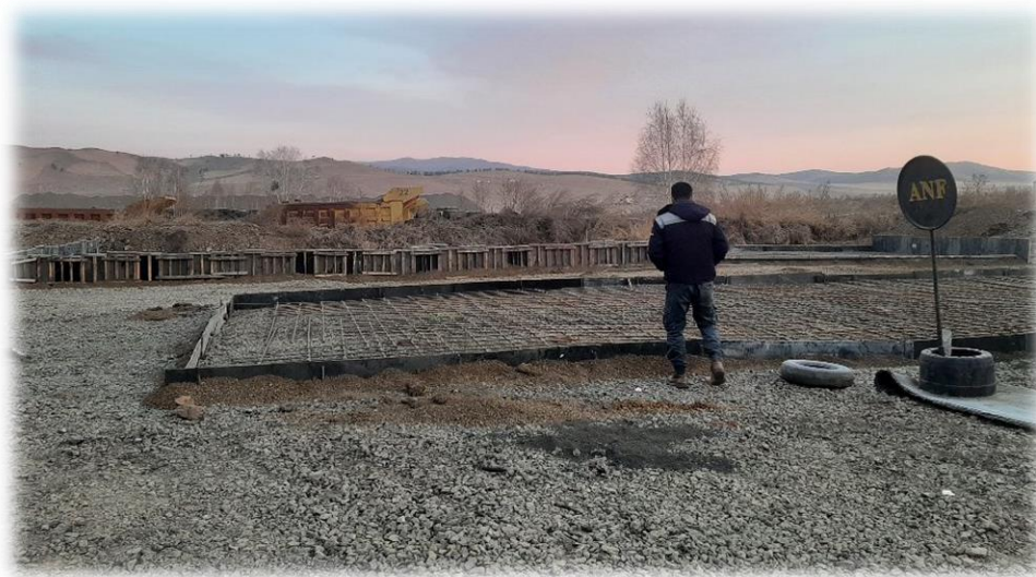
Зураг 5 Арматур зангидаж, бетон цутгахад бэлэн болгосон байдал
