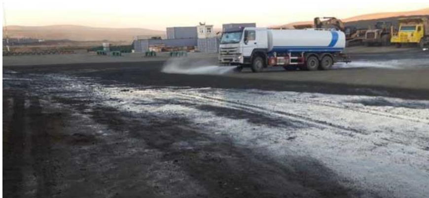
Зураг 1 Уурхайн зам дээр усалгаа хийж байгаа байдал
