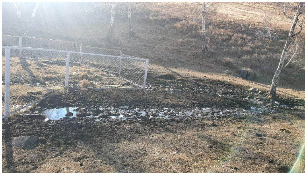
Зураг 25 Булгийн эхийг тохижуулсан байдал
