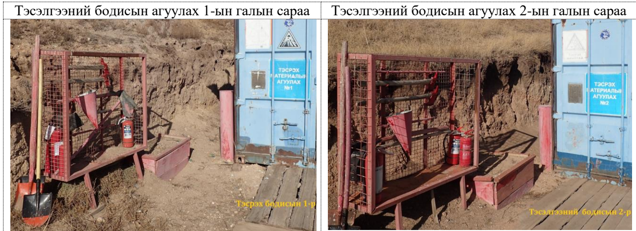
Зураг 26. Уурхайн тосгонд байршуулсан галын булан, болон анхааруулах тэмдэг тэмдэглэгээ
