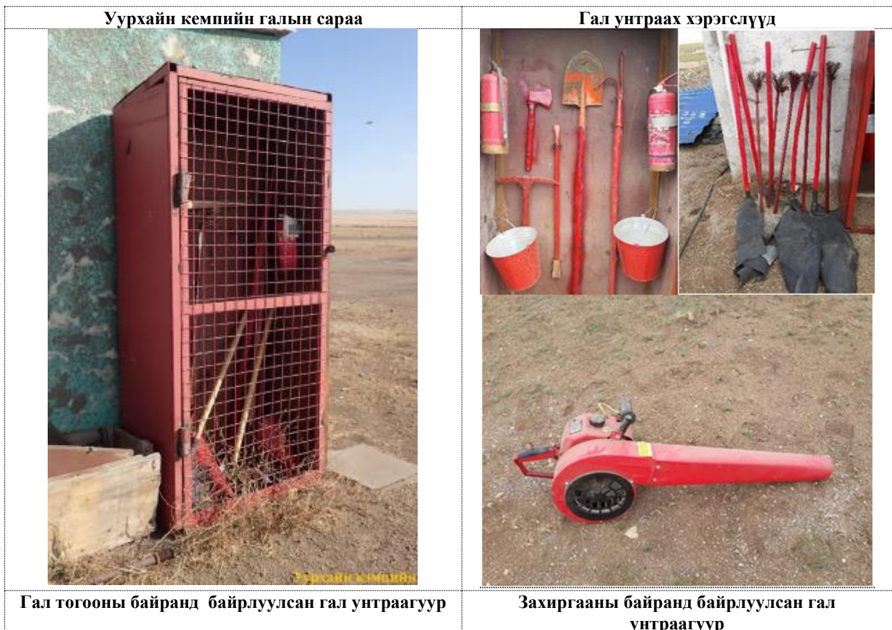
Зураг 26. Уурхайн тосгонд байршуулсан галын булан, болон анхааруулах тэмдэг тэмдэглэгээ
