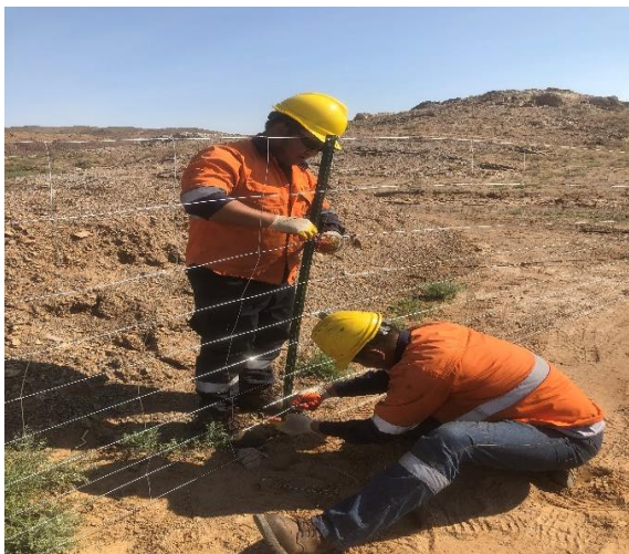
Зураг. 4.4.4 Шингэн хаягдлын далангийн хашаажуулалтыг хийж байгаа байдал
