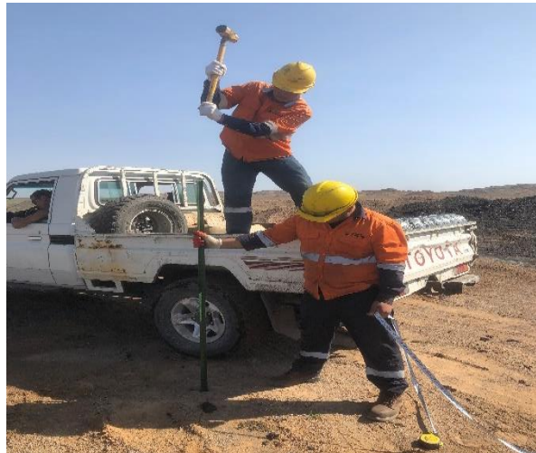
Зураг. 4.4.4 Шингэн хаягдлын далангийн хашаажуулалтыг хийж байгаа байдал
