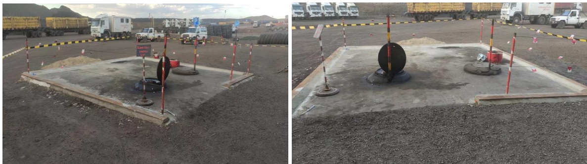
Зураг 9.9. Засварын төвийн хатуу хучилттай талбайг хөмсөгтэй болгосон байдал
