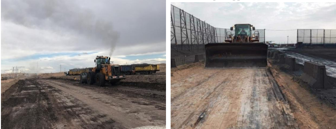
Зураг 4.4.1. НАБТ-н зам, талбайн замын нягтруулалт хийж байгаа байдал
