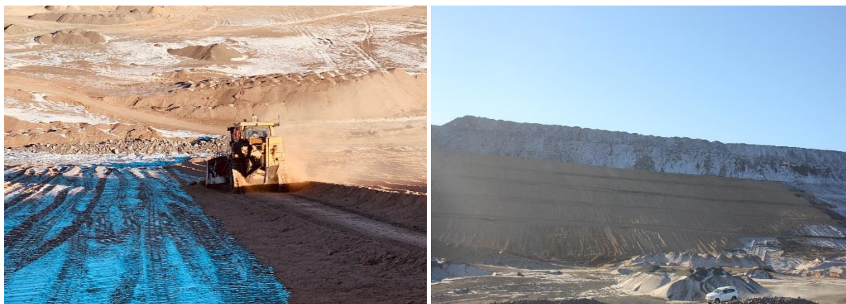
Зураг 5.2.1. Хаягдлын овоолгын хэлбэршүүлсэн талбай дээр шимт хөрсийн хучилт хийж буй байдал
