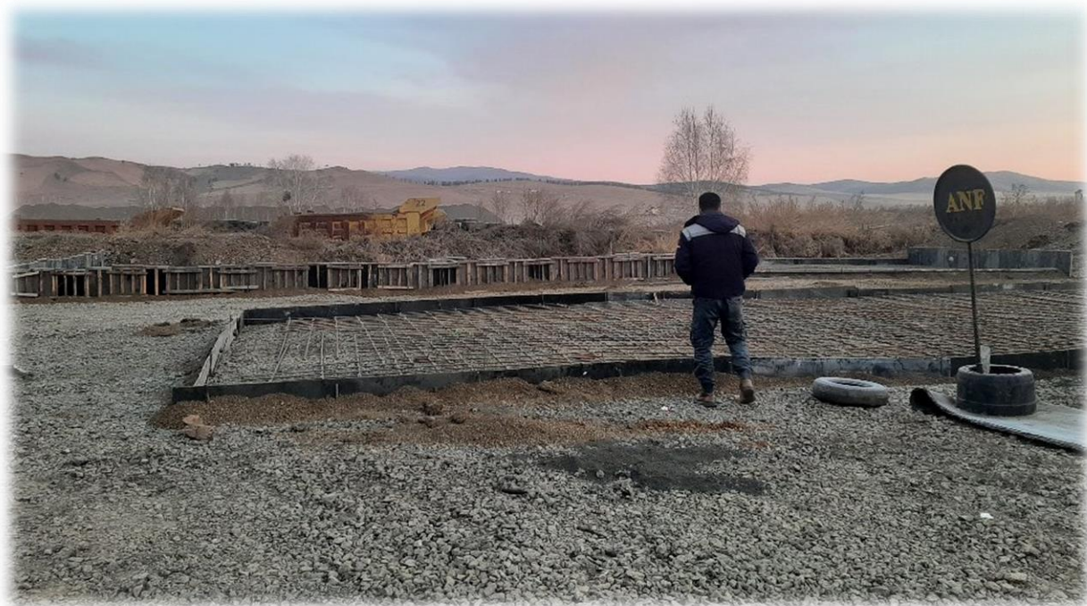
Зураг 10 Арматур зангидаж, бетон цутгахад бэлэн болгосон байдал
