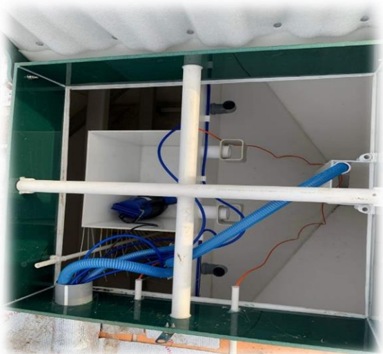
Зураг 8. Кемтийн ахуйн хаягдал бохир ус цэвэрлэх 130 хүний хүчин чадалтай цэвэрлэх байгууламжийг суурилуулж буй байдал
