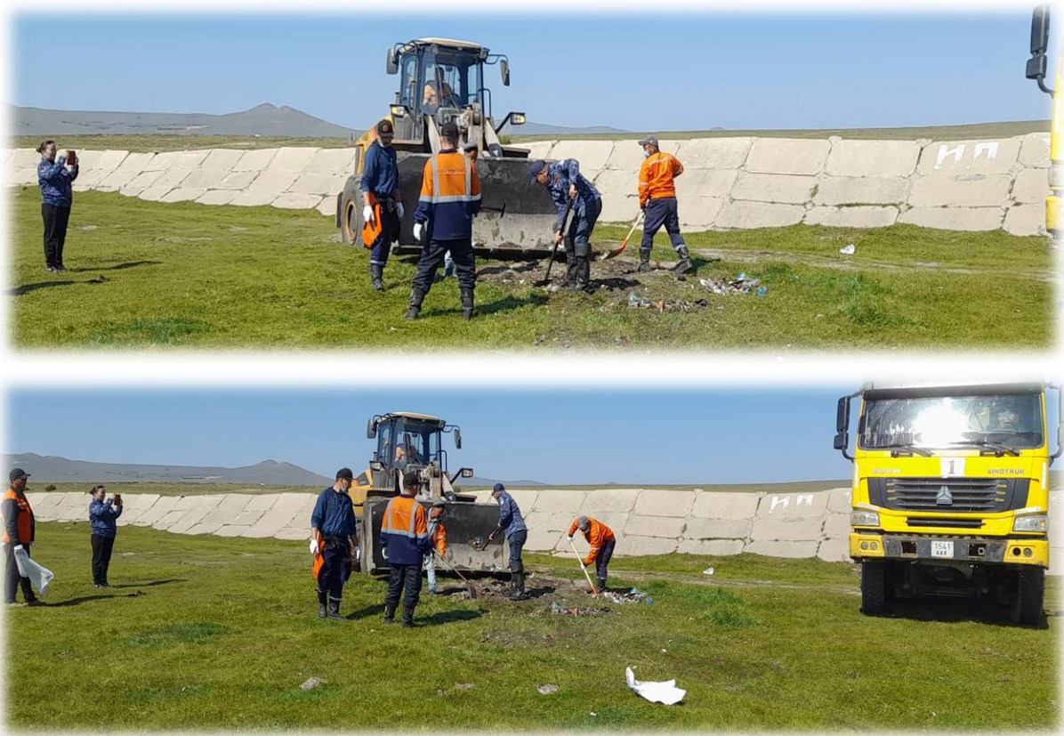
Зураг 28 Голын дагуух хогийг цэвэрлэж буй байдал
