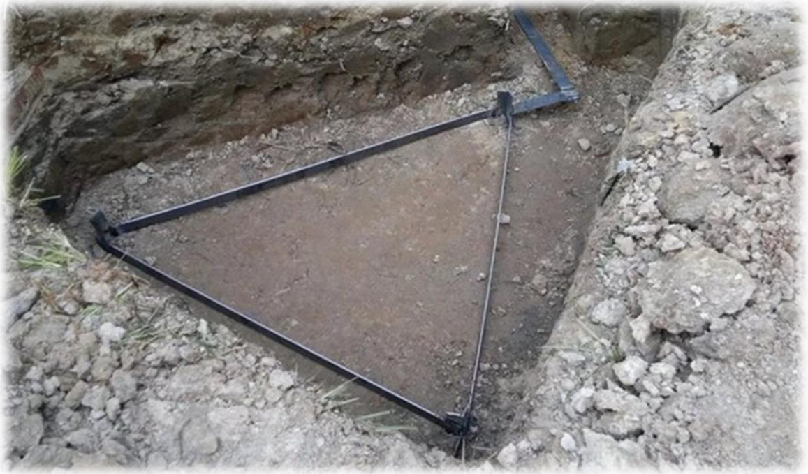
Зураг 17. Газардуулга хийсэн байдал
