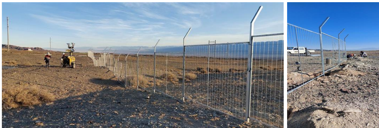
Зураг 10 ХЦ-4 худагт хашаа хамгаалалт хийсэн байдал
