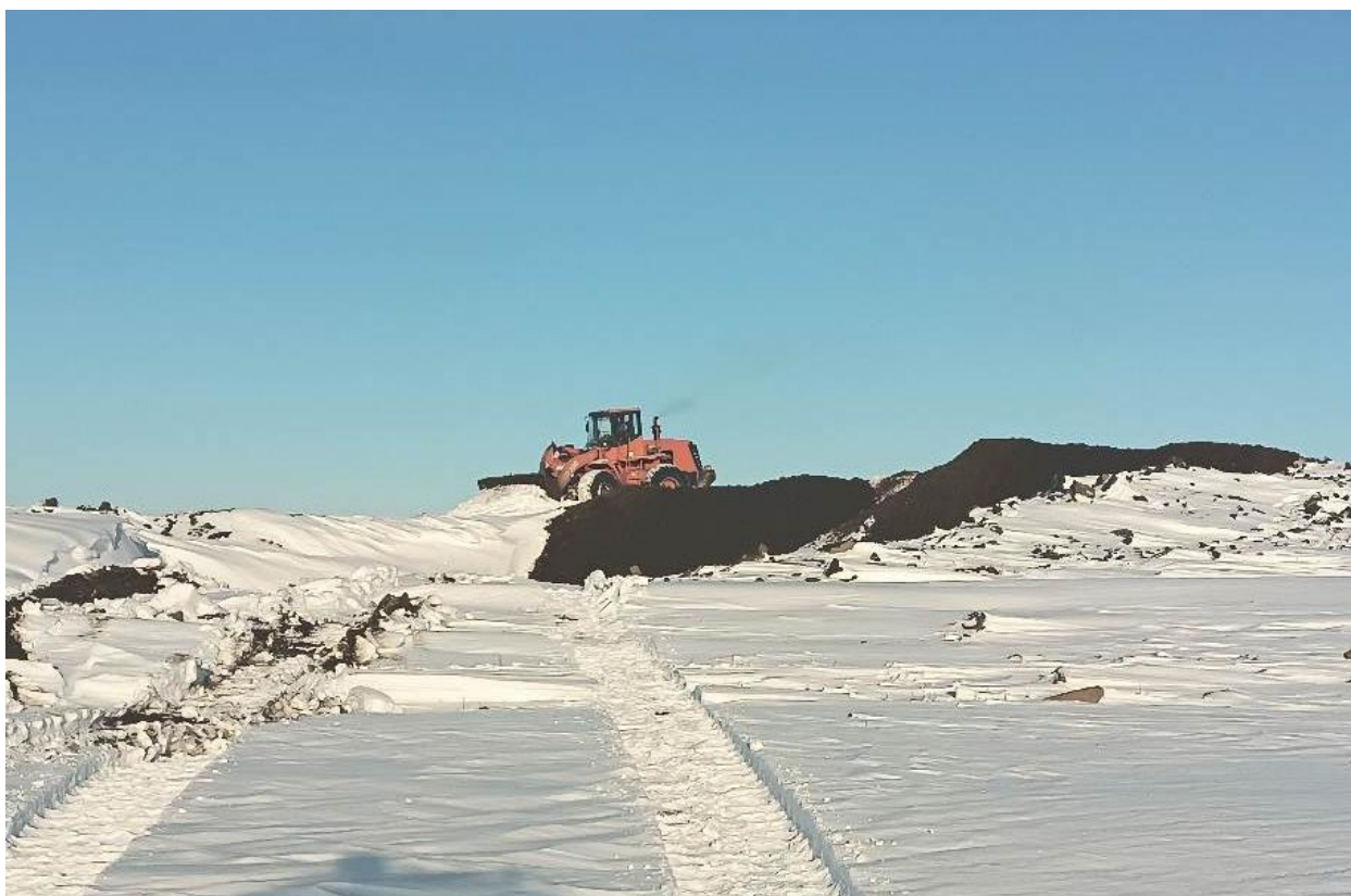
Зураг 3. Техникийн нөхөн сэргээлт хийгдэж буй явцын байдал
