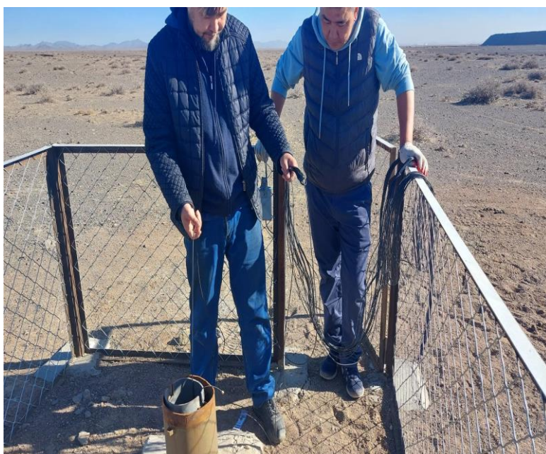
Зураг 18,19 Мониторингийн цооногт суурилуулах хэмжилтийг багаж болон цооногт суурилуулах бэлтгэл ажлын явц
