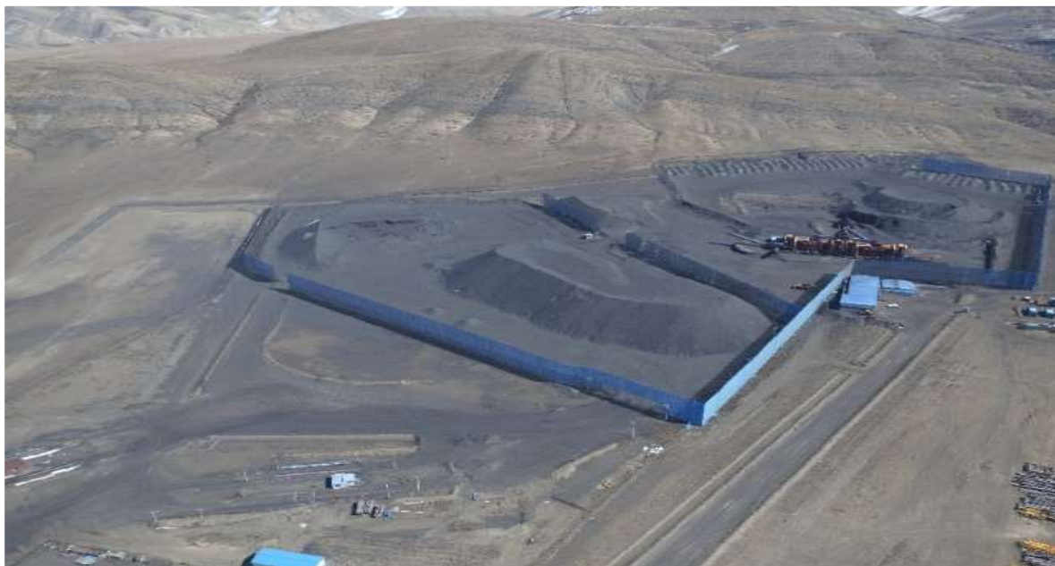
Зураг 68. Тоосжилт бууруулах салхины хурдыг сааруулах 12 метр өндөр торон хашаа
