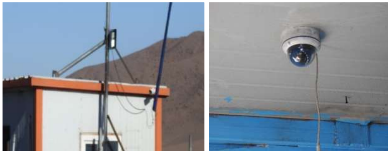
Зураг 6. Худагт суурилуулсан ус ашиглалтын хяналтын камер
