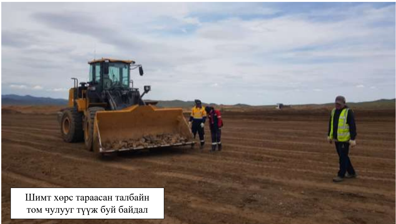
Зураг 26 Шимт хөрсний хучилтын ажил буюу Шимт хөрс дэвссэн байдал
