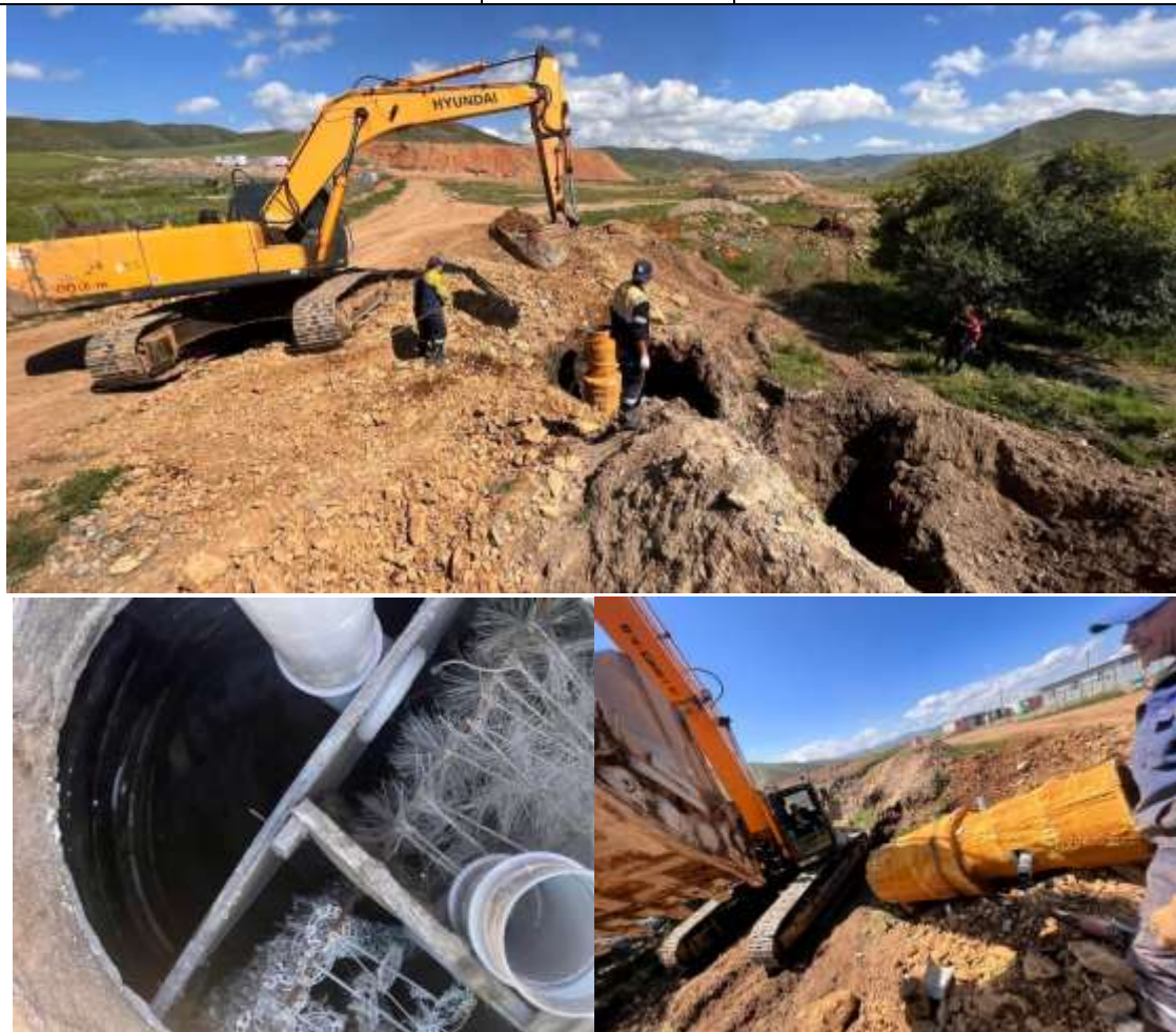
Зураг 40 Ахуйн шингэн хаягдал боловсруулах танк суурьлуулалтын ажил
