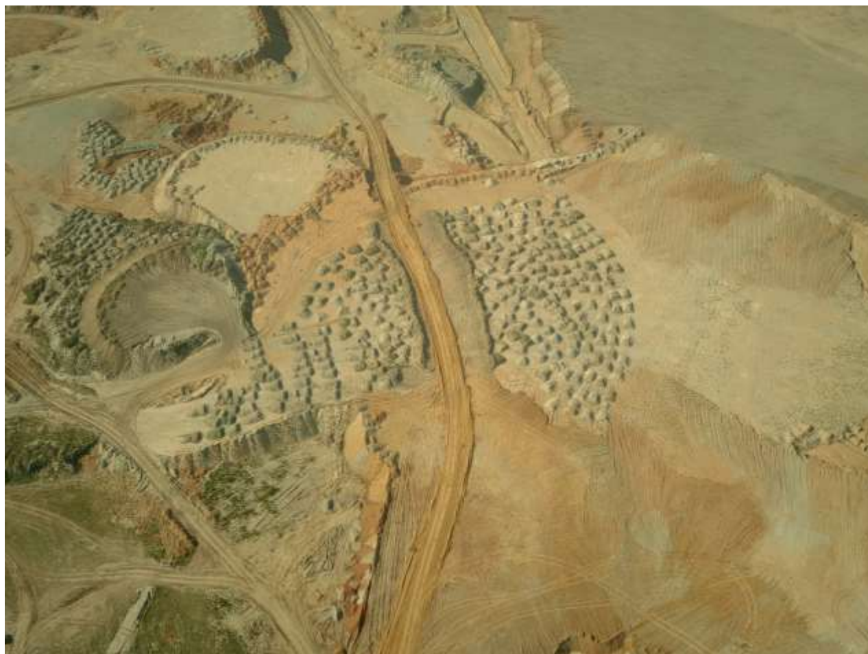
Зураг 24 Дотоод овоолго үүсгэх замаар нөхөн сэргээлтийн ажил хийгдэж буй байдал
